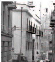
La cabina elettrica progettata in forma di palazzo in via Giuseppe D'Alessi
