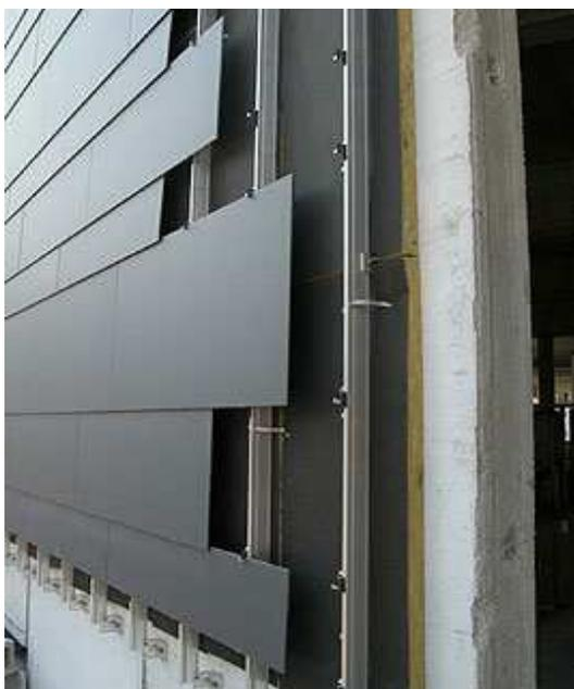
**Fig.2.** Esempio di parete ventilata con rivestimento in pannelli metallici
