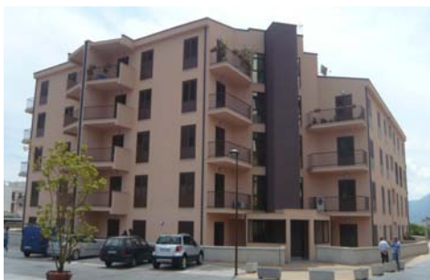
Figura 4. Edificio con finitura ad intonaco silossanico
