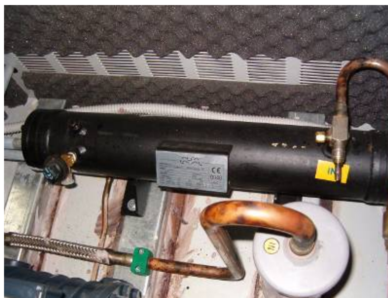
Figura 4.30 Condensatore Alfa Laval CFC-12 CE.
