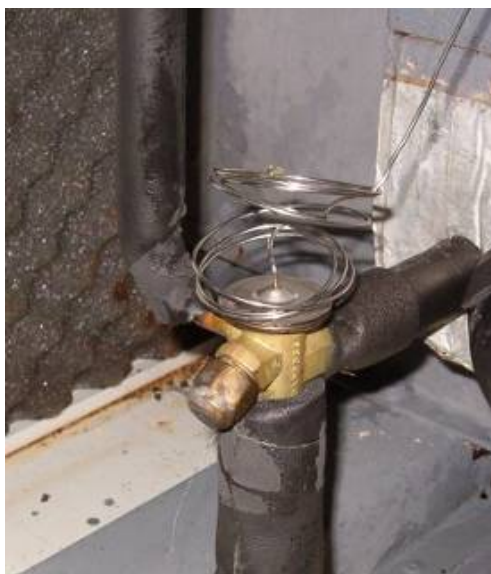
Figura 4.36 Valvola di espansione termostatica DANFOSS TES2.
