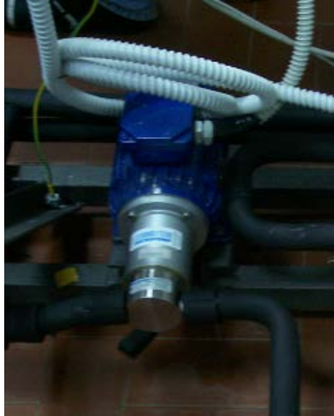
Figura 4.12 Pompa a trascinamento magnetico.
