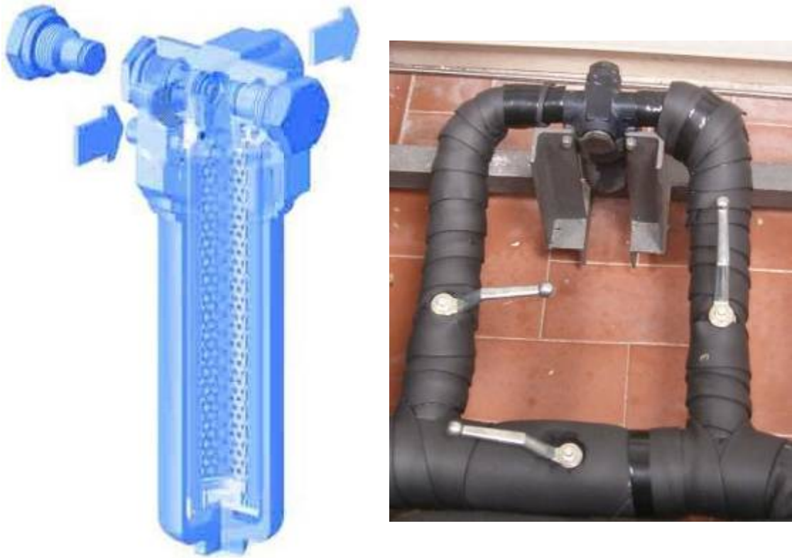
Figura 4.22 Filtro e circuito di bypass.
