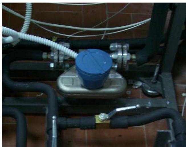
Figura 4.46 Misuratore di portata massica ad effetto Coriolis.
