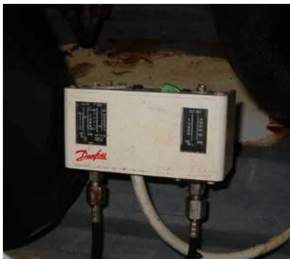
Figura 4.40 Pressostato di massima.
