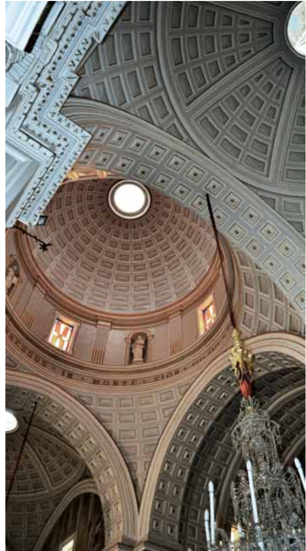
43. Attard (Malta). Chiesa di Santa Maria Assunta (dal 1613), transetto (foto di C.Thake).
