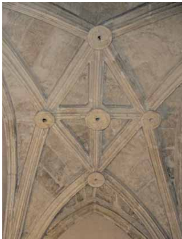
26. Alghero. Chiesa di San Francesco, volta di una cappella. Si noti l'eliminazione dei costoloni diagonali.
