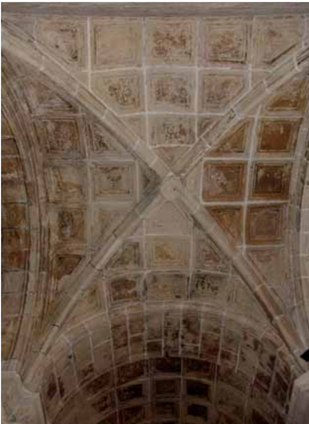
38. Valletta. Sacra infermeria (1574), volta a crociera cassettonata con costoloni (fototeca del Dipartimento di Architettura, Palermo).
