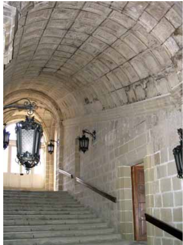
39. Valletta. Sacra infermeria, volta a botte inclinata con cassettoni (fototeca del Dipartimento di Architettura, Palermo).
