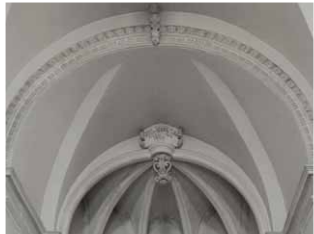
30. Minervino. Chiesa di San Michele Arcangelo, copertura dell'abside.
