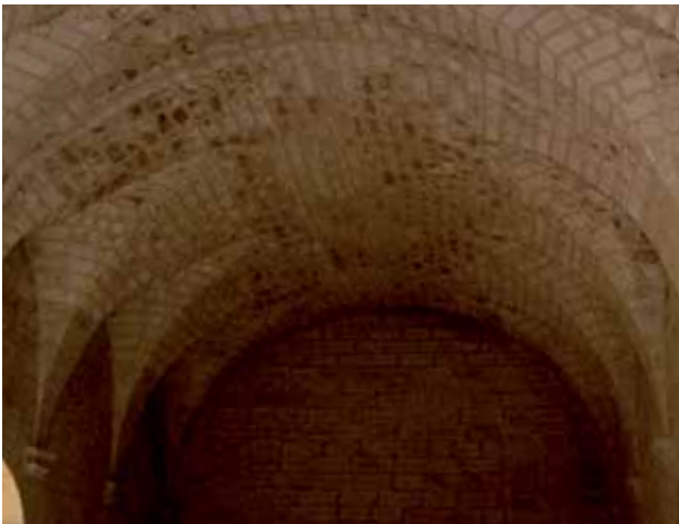
29. Acaya. Castello, sala con volta a botte lunettata, si veda l'andamento diagonale dei conci delle “mpise” (foto di M. M. Bares).
