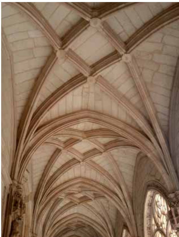
25. Toledo. Monastero di San Juan de los Reyes, crociere senza costoloni diagonali nel chiostro.
