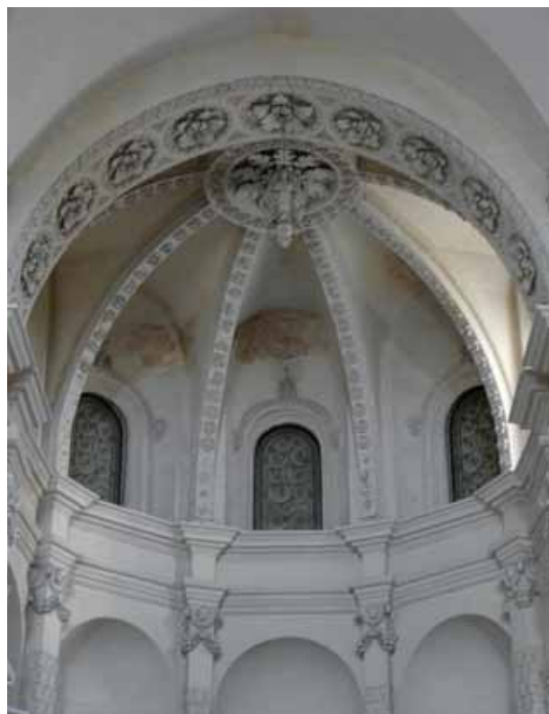
28. Lecce. Chiesa di Santa Croce, copertura dell'abside.
