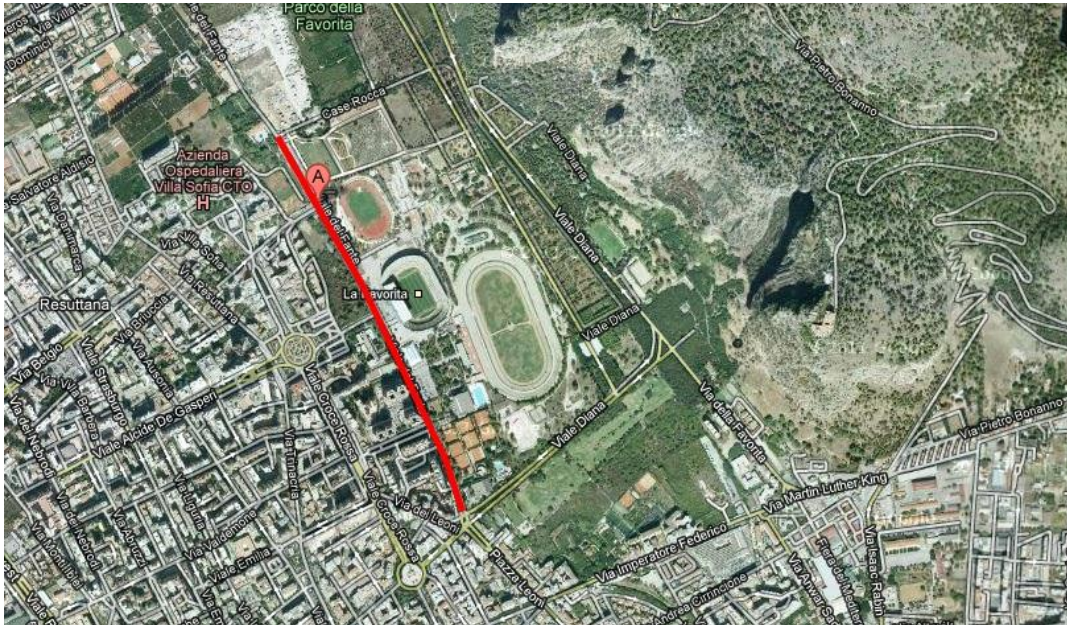
Figura 4.14 - Vista satellitare di via del Fante
