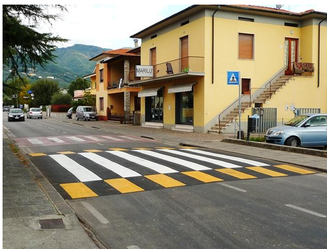
Figura 2.2 - Attraversamento pedonale rialzato
