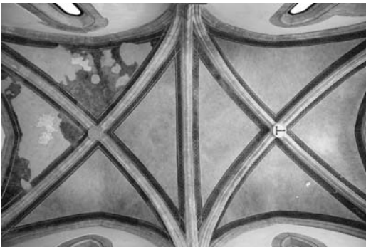
Figura 8 Bóvedas de crucería en la pequeña iglesia de San Antonio (Steri) en Palermo (foto del autor 2013)
