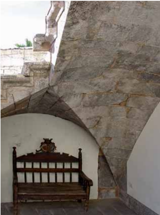
1. Valencia. Palacio de Faura, escalera con encuentros de bóvedas por arista.
