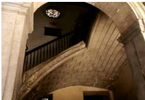
29. Granada. Patio renacentista de la Real Chancillería, gran escalera adulcida en cercha .
