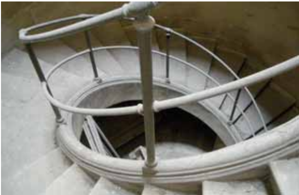
7-8. Particolari della scala con la ringhiera in ferro battuto.
