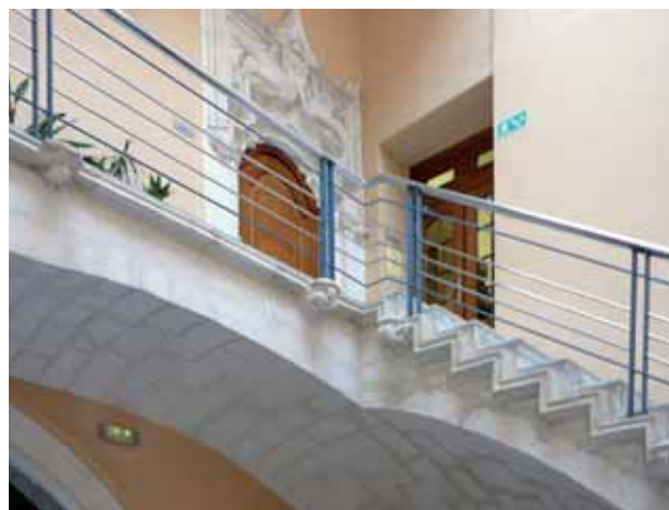
2. Onteniente. Palacio de los Sancho, escalera con encuentros de bóvedas por igual.
