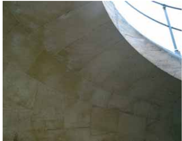
I4. Vista dell'intradosso dei gradini.
