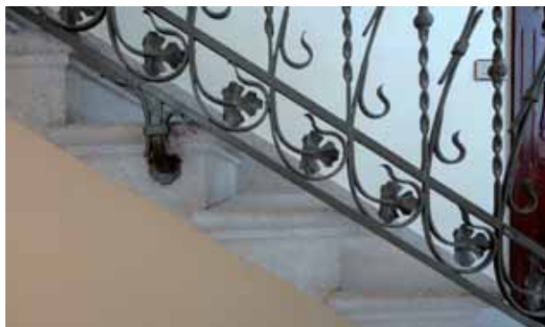
I-2. Trapani. Casa Ferrante, 1908, scala vista dall'alto e particolare del gradino.
