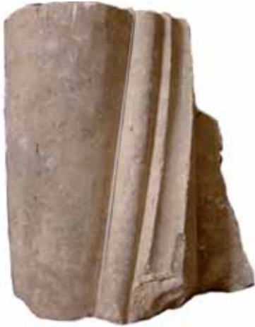
31. Noto Antica. Chiesa di Santa Chiara, frammento di scala elicoidale con nocciolo centrale singolare.
