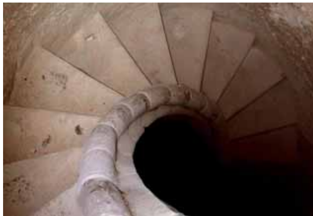
19. Sortino. Chiesa del Collegio, particolare del montante elicoidale della scala con "curva e controcurva" (foto G. Alfano).
