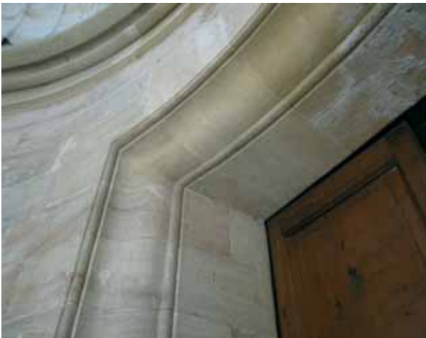
I3. Particolare dell'architrave curva del vano porta.
