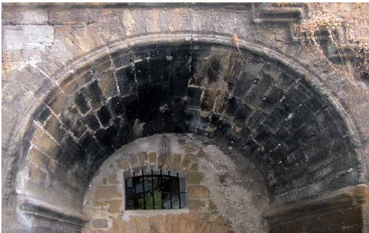
7. Particolare dell'arco abocinado a sostegno della scala.
