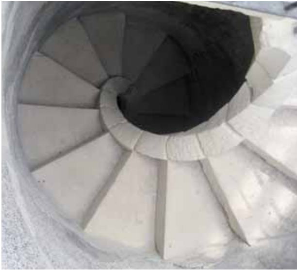
22. Catania. Chiesa della Badia di Sant'Agata, scala con montante elicoidale a forme semplici e geometrie ortogonali.
