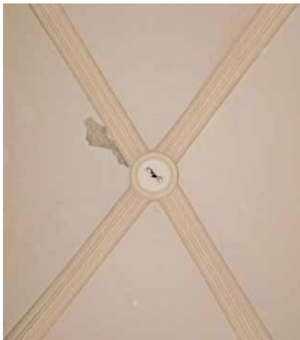
4. Volta a crociera in una delle sale del piano nobile.
