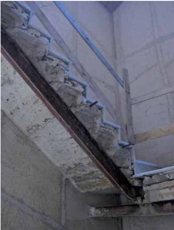
7. Palermo. Palazzo di Martino Minolfo, dettaglio dell'intradosso di una rampa all'intersezione con un tavoliere intermedio della originaria scala "alla trapanese".
