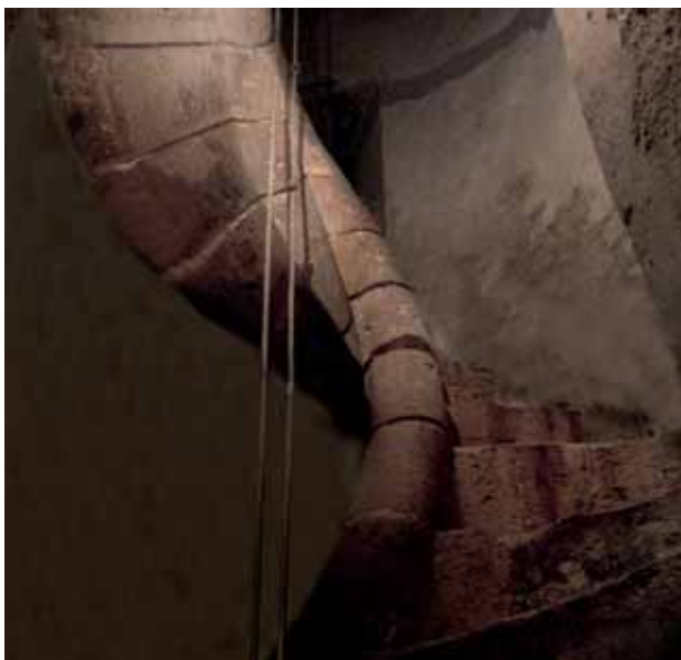
20-21. Noto. Chiesa di San Francesco d'Assisi all'Immacolata, accesso alla scala elicoidale e particolare del peculiare raccordo curvo tra la superficie verticale di alzata del gradino e il cordolo..
