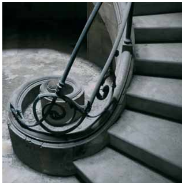
9. Particolare della spirale del gradino di invito (foto G. Papa).
