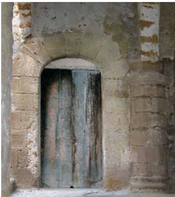
3. Particolare del cortile con il semipilastro poligonale.
