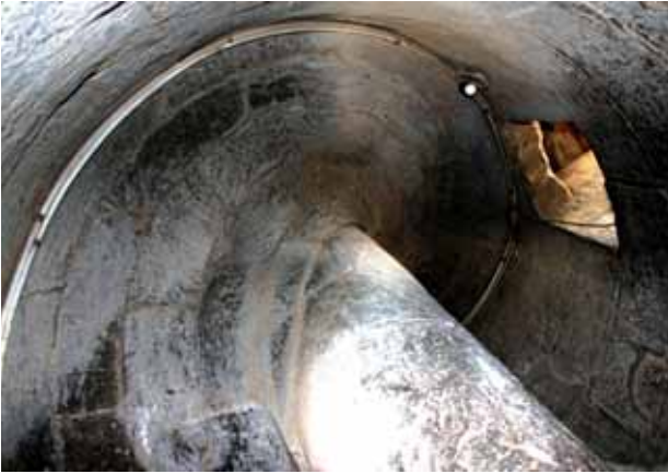
16. El Cairo. Madraza Al Ghoury, escalera de caracol en vía de San Gil de cinco dovelas en uno de los minaretes, primer cuarto del XVI.
