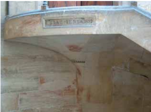
2. Particolare della scala con l'incisione del nome di Carlo Giachery e l'anno di realizzazione dell'opera.
