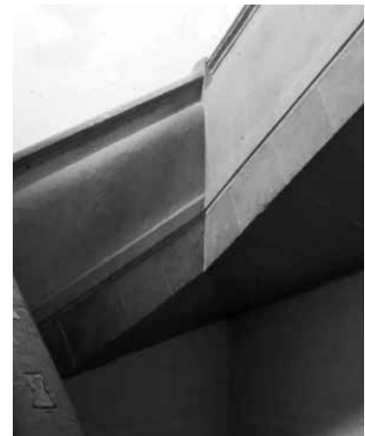
32. Sevilla. Real Casa de Contratación (hoy Archivo de Indias), escalera adulcida a regla .
