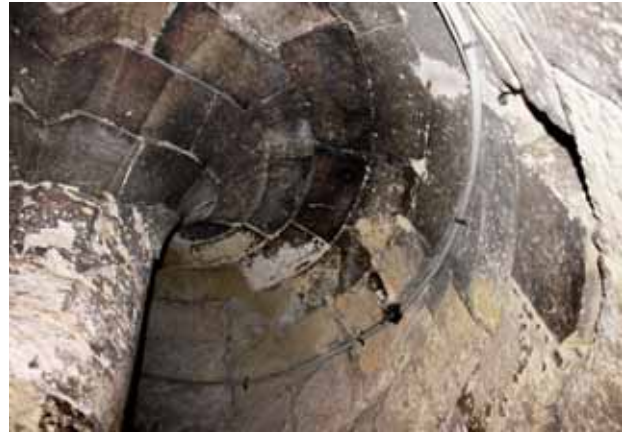
17. El Cairo. Universidad Al Azahar, escalera de caracol en vía de San Gil de siete dovelas en uno de los minaretes, siglo XVI ca.
