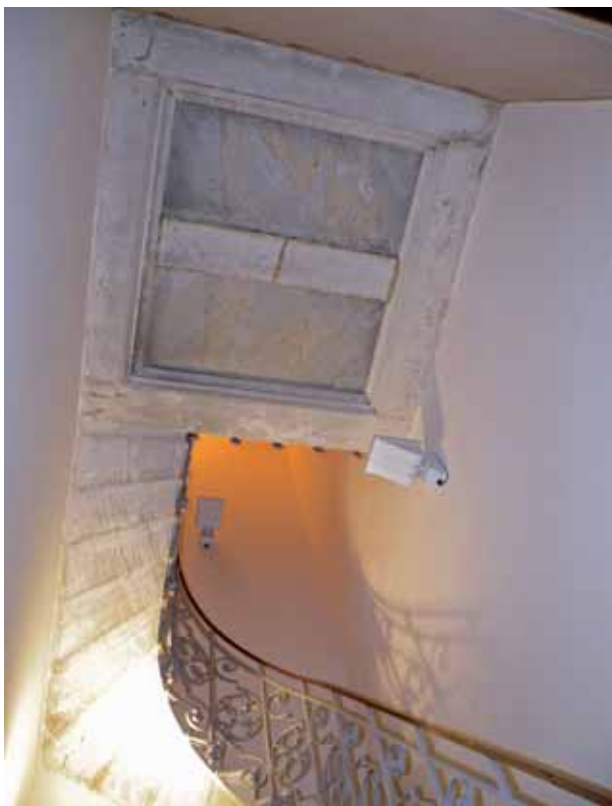
6. Trapani. Villino Nasi, sopraelevazione del 1913, particolare del pianerottolo d'arrivo.
