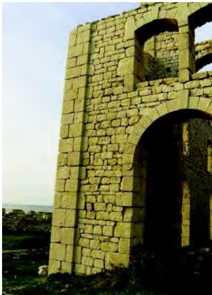
Cantonale realizzato con grandi blocchi in leggero aggetto rispetto al piano della muratura. (Foto C. Bustinto).
