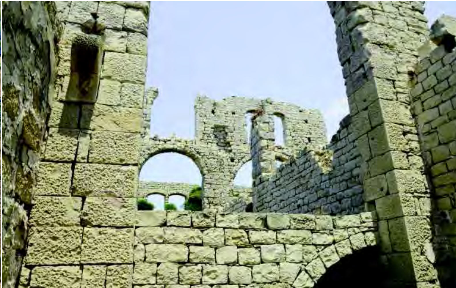
Porzione delle strutture murarie del vano adibito alla fabbricazione degli stampi. Si può ancora vedere una porzione dell'arco di scarico della scala in muratura che conduceva al primo piano. (Foto C. Bustinto).
