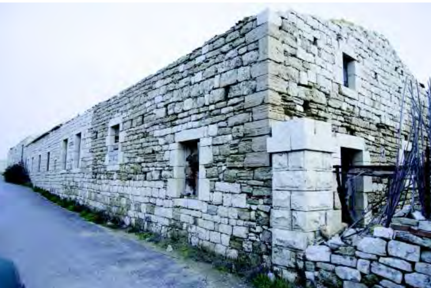
Porzione del fronte nord dell'impianto. Le costruzioni si presentano ancora oggi in discrete condizioni. (Foto C. Bustinto).
