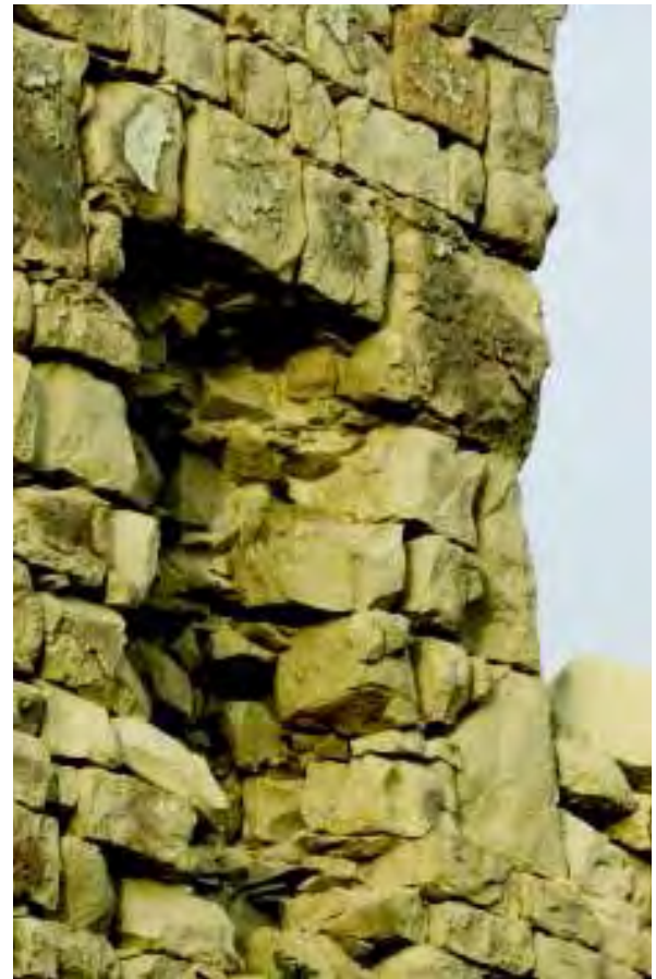
Dettagli della struttura muraria in cui si evidenzia la tecnica di posa in opera dei conci. (Foto C. Bustinto).
