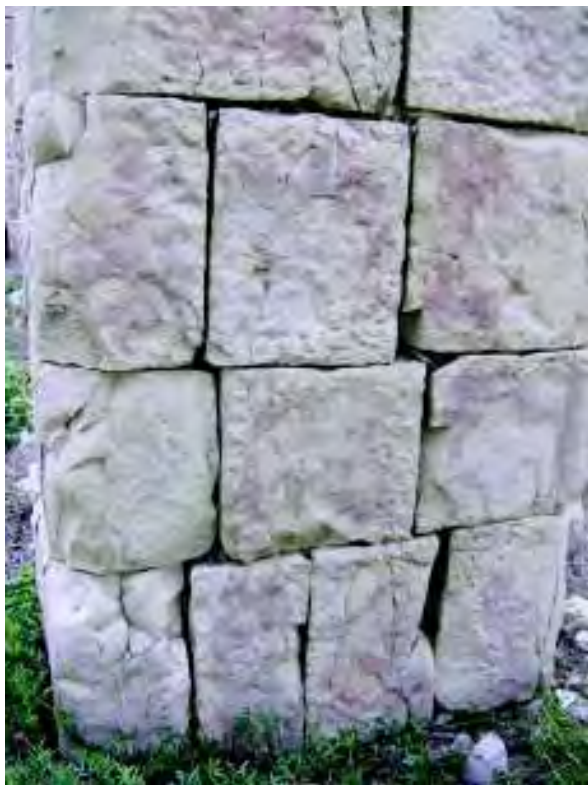
I blocchi di calcare forte calcificati dall'incendio. (Foto C. Bustinto).
