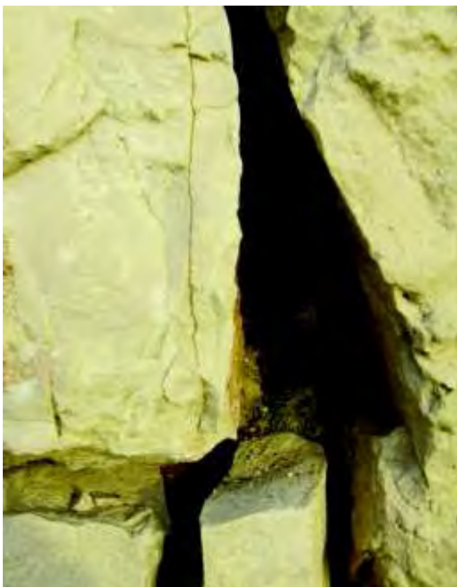
Dettaglio delle connesure tra i conci in cui si evidenzia la mancanza della malta erosa dall'azione meteorica. (Foto C. Bustinto).
