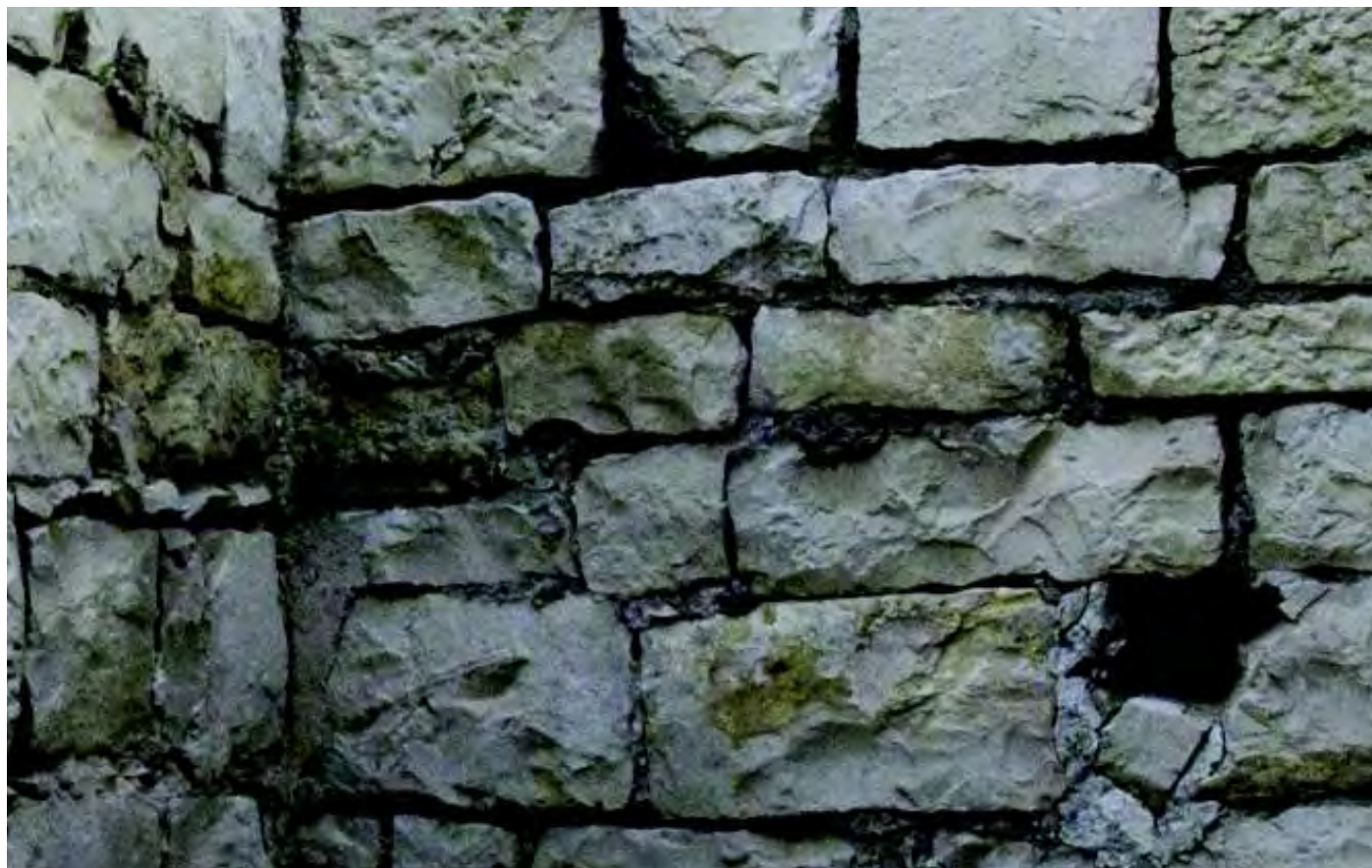
Dettaglio di alcuni conci costituenti una porzione del paramento di un setto murario interno. (Foto C. Bustinto).
