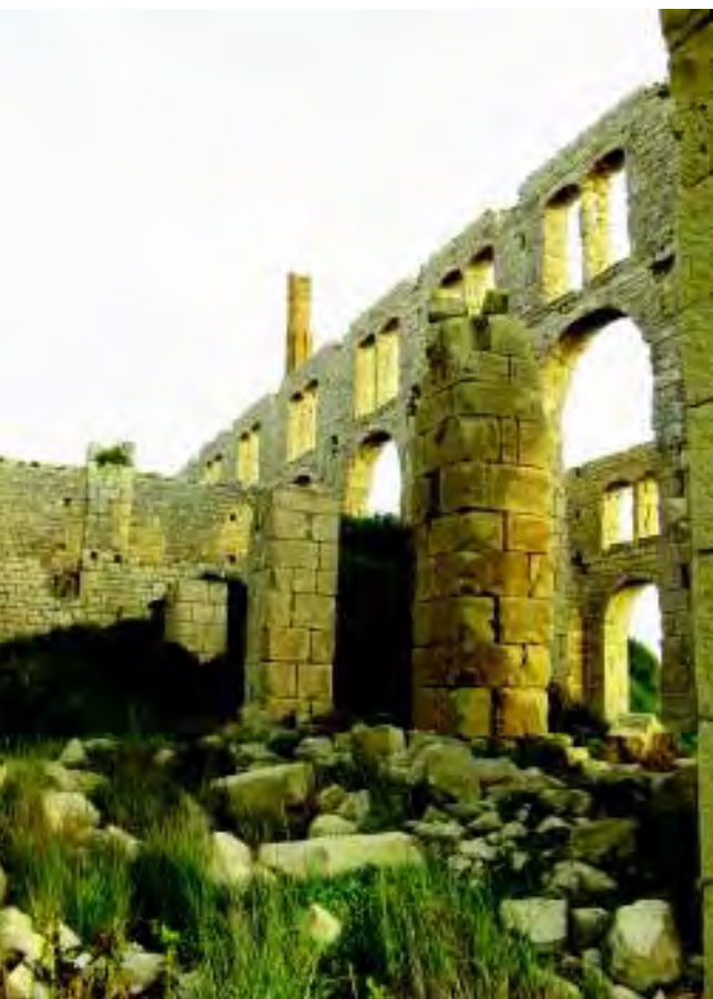
Le strutture superstiti del manufatto, invaso dalla vegetazione e disseminato dai blocchi che costantemente ed inesorabilmente cadono al suolo. (Foto C. Bustinto).
