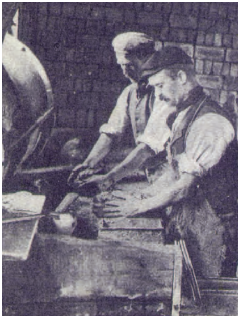
Due operai impegnati nella modellatura dei pezzi all'interno di una fabbrica di laterizi. ( http://www.milanoneicantiereidellarte.it ).
