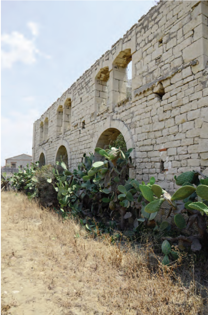
Una porzione dell'attuale prospetto nord della fornace. Si possono ancora scorgere le tracce degli innesti della parte di fabbricato fatta costruire successivamente. (Foto C. Bustinto).
