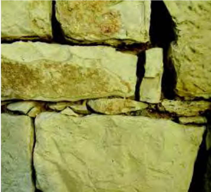
Schegge di calcare inserite tra un concio e l'altro. (Foto C. Bustinto).
