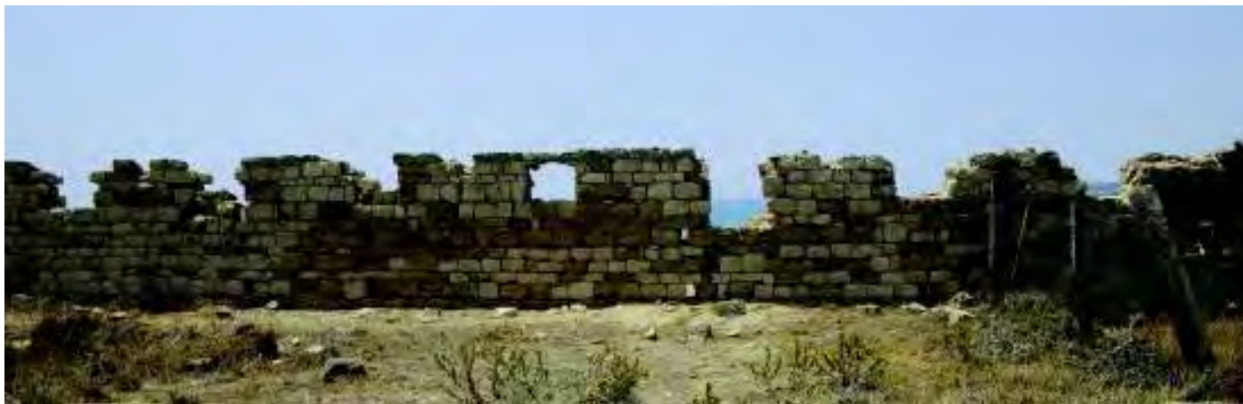
I ruderi del muro sul fronte a mare, forse quel che resta di corpi di fabbrica a servizio dell'opificio, forse un semplice muro di confine dell'impianto. (Foto C. Bustinto).
