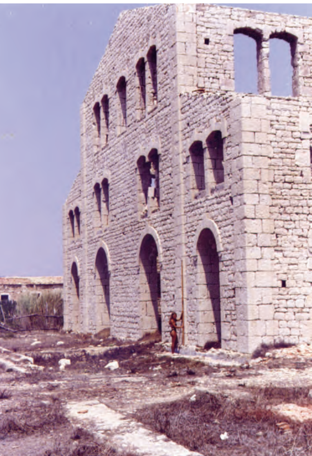
Il prospetto sud dell'edificio principale fotografato durante le operazioni di rilievo effettuate nell'estate del 1989. (Foto G. Firrone).
