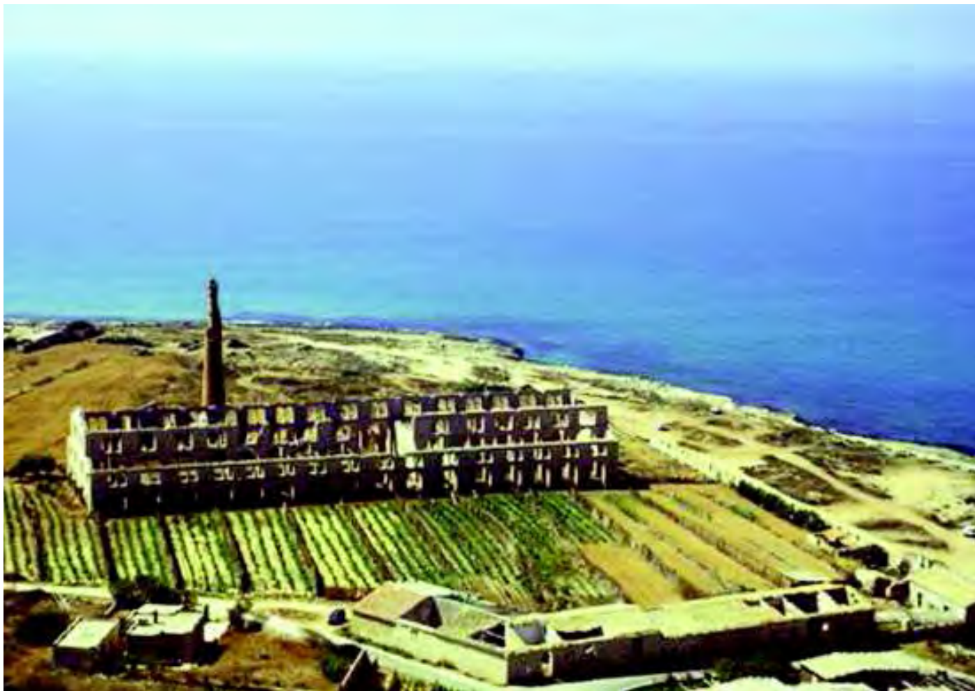
Veduta panoramica dell'impianto. (Foto aerea di Paolo Nifosi).
