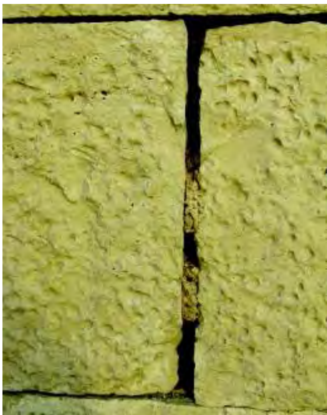
Dettaglio delle connesure tra i conci in cui si evidenzia la mancanza della malta erosa dall'azione meteorica. (Foto C. Bustinto).
