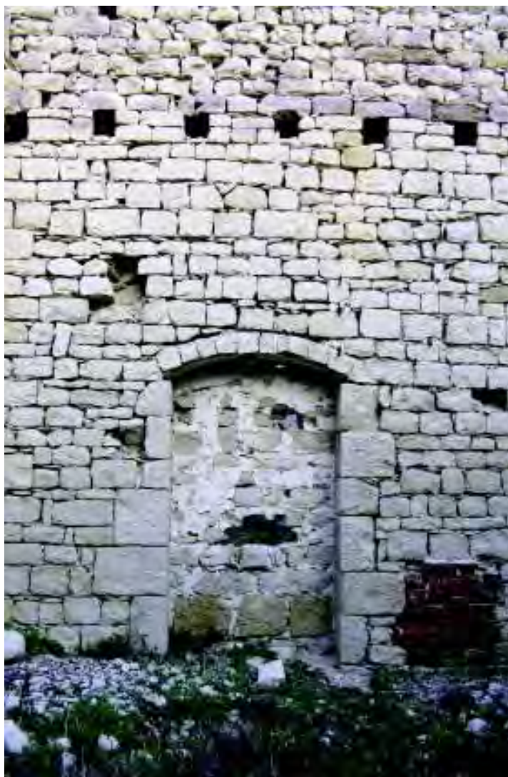
Porzioni di muratura in cui è possibile vedere i fori per l'alloggiamento delle travi e i blocchi lapidei più scuri, proprio al di sopra delle travi di solaio, perchè più intensamente colpiti dalle fiamme. (Foto C. Bustinto).
