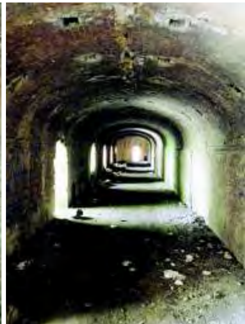
Porzioni del corridoio ellittico del forno (foto F. Palazzolo e C. Bustinto).
