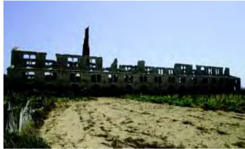
Prospetto nord. (Foto F. Palazzolo).
