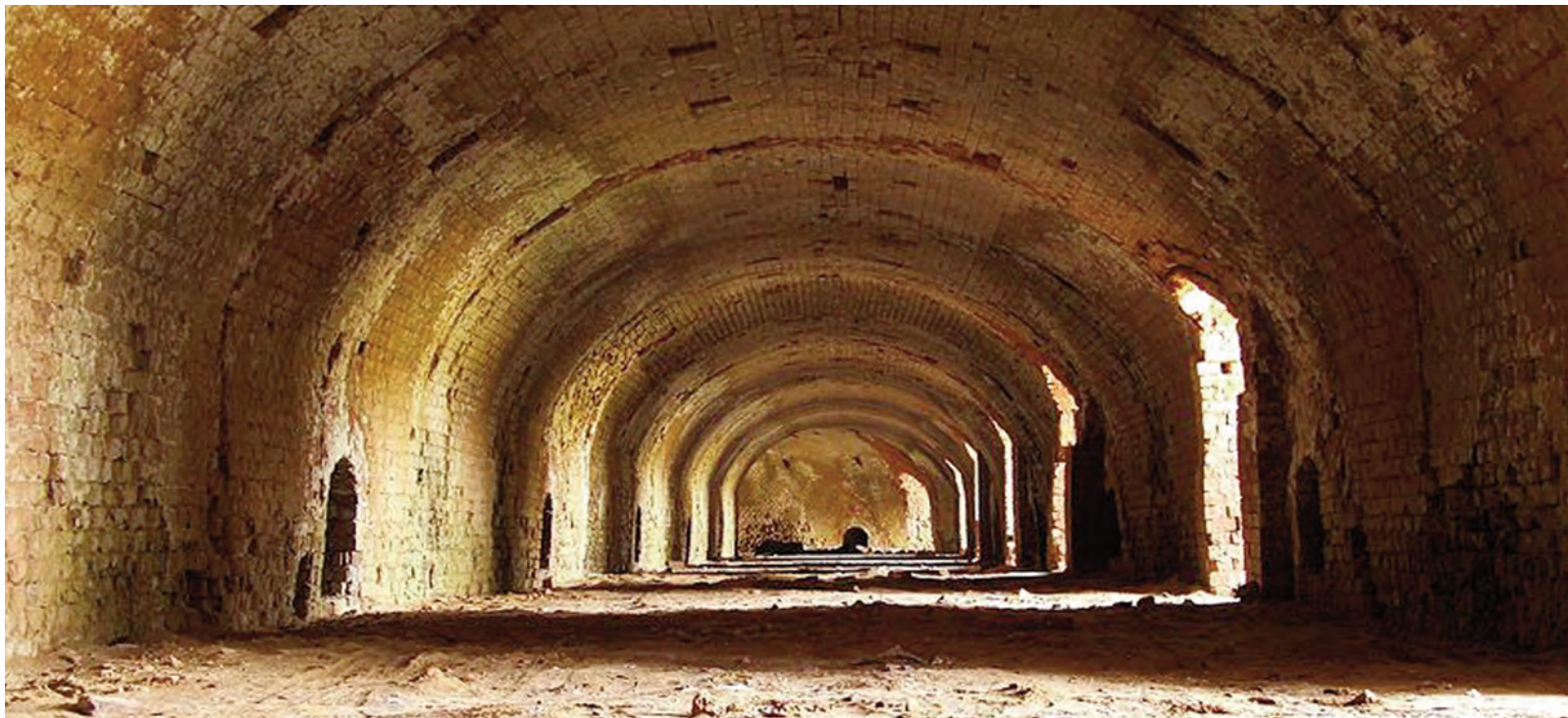
Camera di cottura di un forno Hoffmann a galleria ellittica.
