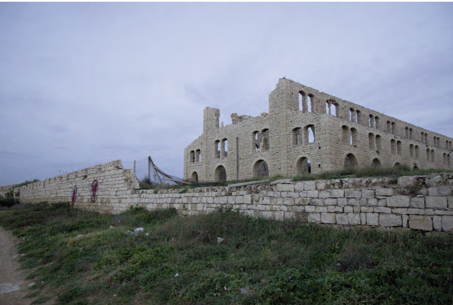
Recinzione divelta. (Foto C. Bustinto).
