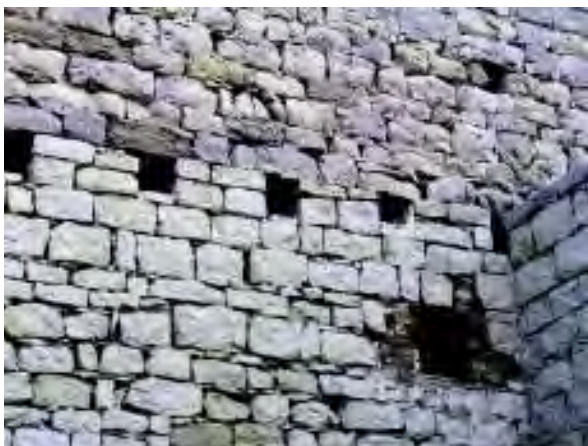
Porzioni di muratura in cui è possibile vedere i fori per l'alloggiamento delle travi e i blocchi lapidei più scuri, proprio al di sopra delle travi di solaio, perchè più intensamente colpiti dalle fiamme. (Foto C. Bustinto).
