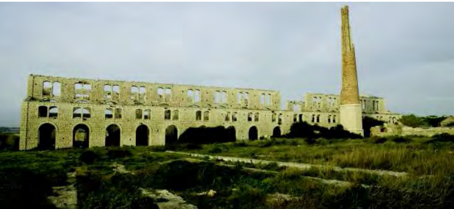
Tracce delle strutture murarie costituenti gli essiccatoi. (Foto C. Bustinto).
