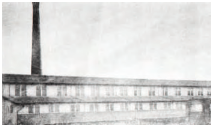
A destra, foto tratta dall'articolo apparso sul giornale La Sicilia del 12 luglio 2004. L'immagine ritrae il fianco nord della fornace sul quale è innestato il nuovo corpo di fabbrica.
