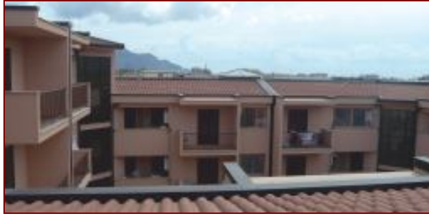
Figura 5.27 Vista di una delle due terrazze dell'edificio
