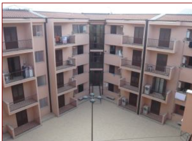
Figura 5.26 Vista della corte interna dalle terrazze di copertura
