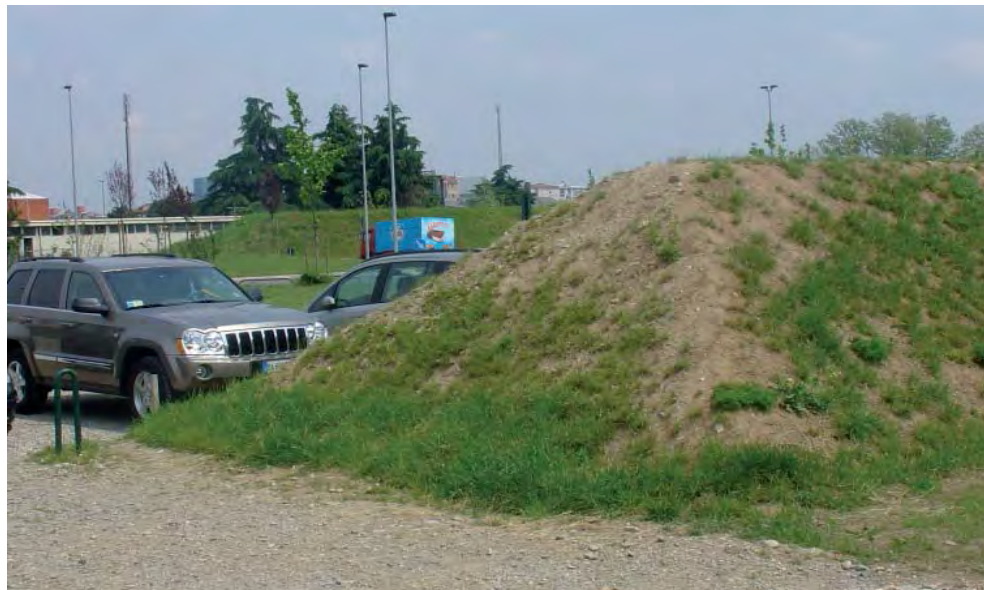
1. Terrapieni antirumore nel Parco Nord Milano (G. Sanesi)
