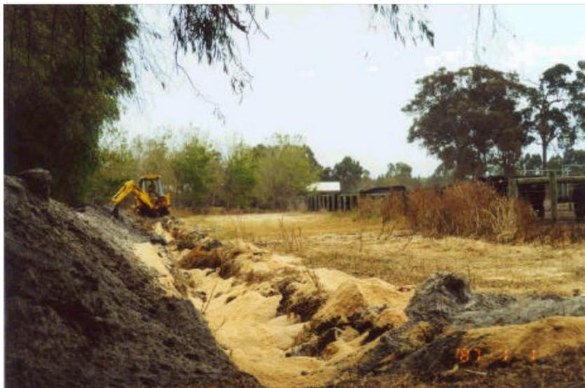
**Fig. 3.10 Immagine della biobarriera riempita con segatura (Fahrner, 2002)**
