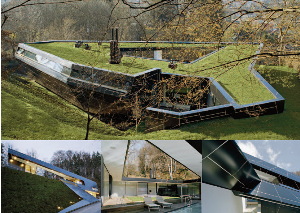
House RT, Wien, Austria, 2005.
