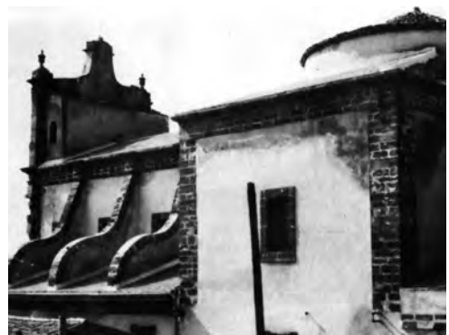
Fig. 22. Salaparuta vecchia. Veduta posteriore della chiesa Madre prima del terremoto del 1968, particolare (coll. p.).
