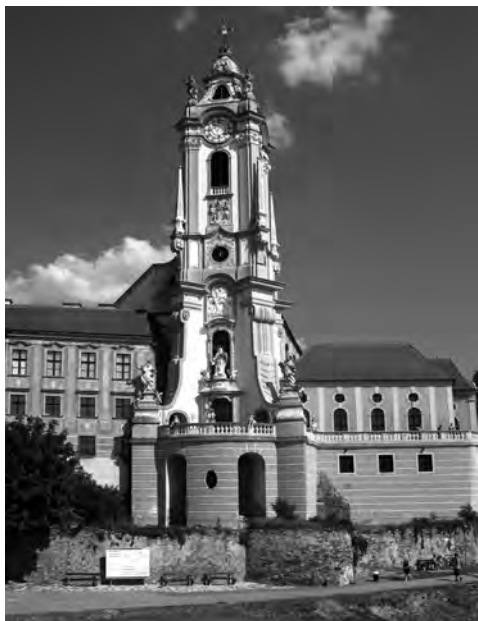
Fig. 10. Durnestein. Chiesa dell'abbazia, veduta del campanile (da Nobile 2008).
