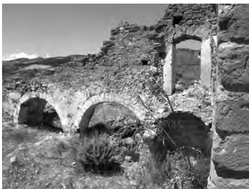
Fig. 21. Salaparuta vecchia. Veduta dei ruderi della chiesa Madre dopo il terremoto del 1968, particolare delle strutture di contenimento in corrispondenza della zona absidale.
