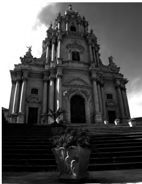
Fig. 2. Ragusa. Chiesa di San Giorgio, veduta esterna.
