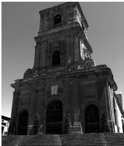
Fig. 5. Enna. Duomo, facciata campanile, veduta esterna.
