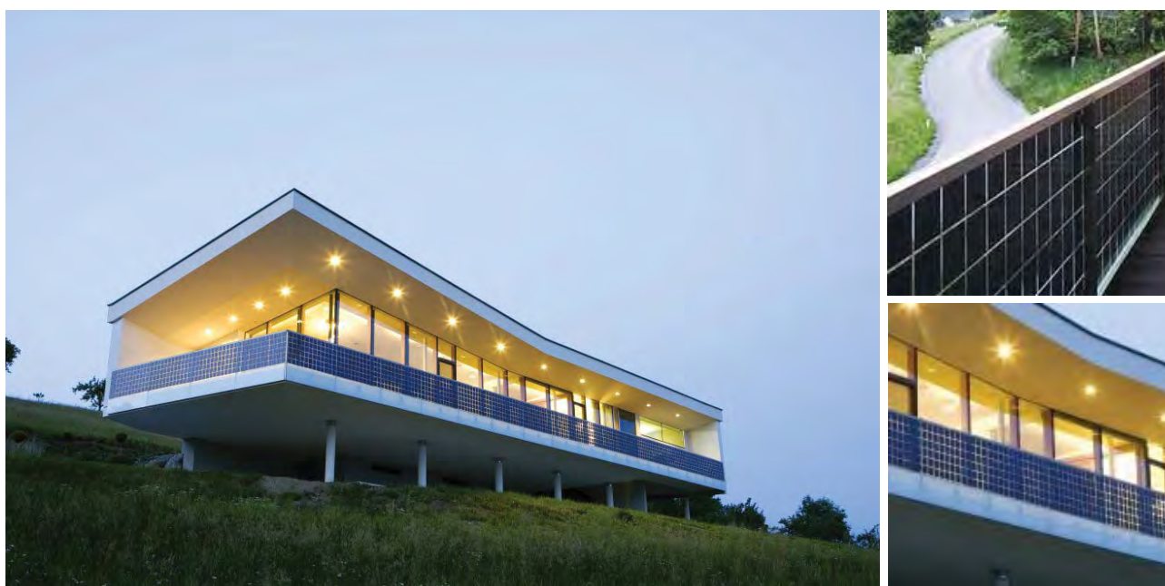
Fig. 6 - Kaltenegger, Casa unifamiliare, Passail, Austria, 2007. Vista dei fronti sud ed ovest e dettagli dell'installazione FV
