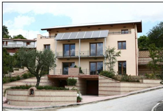
Fig. 1 - Facciata sud della LH
