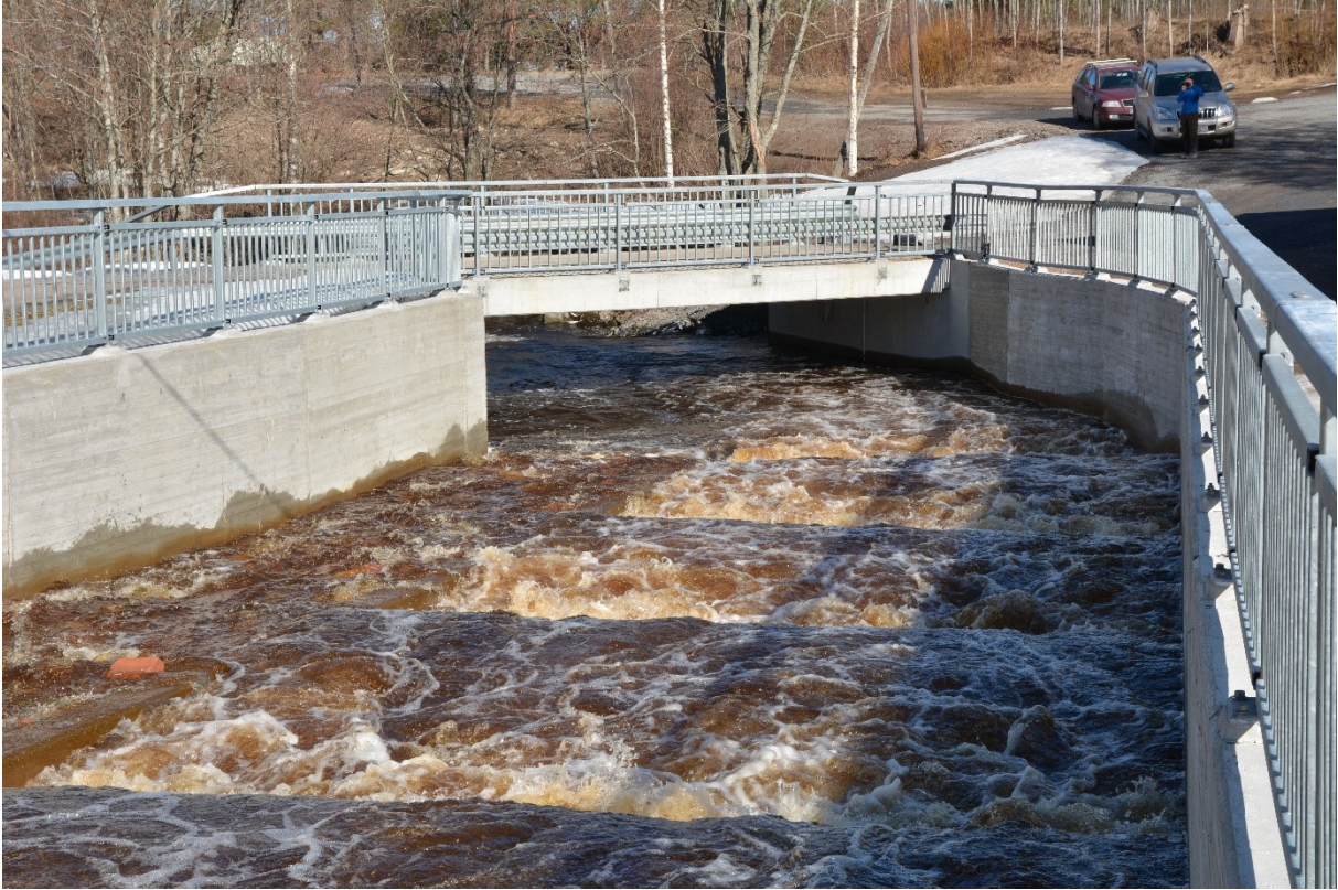
Kuva 5. Villamon padon tilalle rakennettu tekninen vaellusyhteysratkaisu, jota kautta kulkee koko joen vesimassa. Kuva: Panu Orell.
