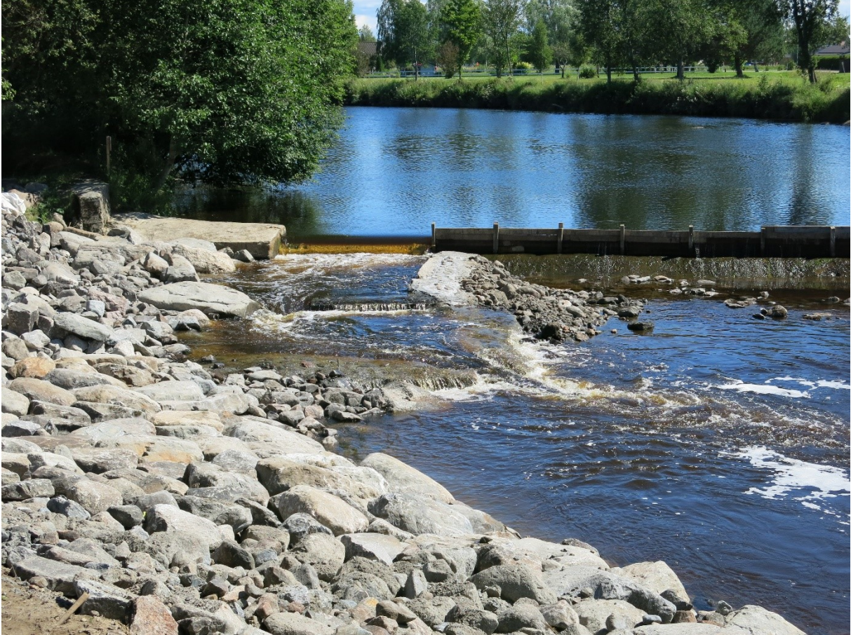
Kuva 3. Sandgrundforssin pohjapato ja kalatie alhaisella kesävirtaamalla. Kuva: Teemu Huovinen.
