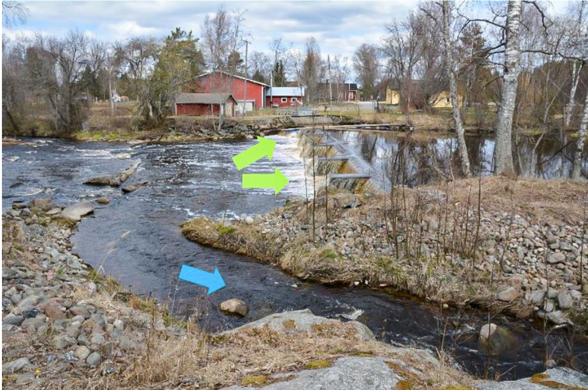
Kuva 15. Radiotaimenten nousureitit Peruskosken padon ohitse kesällä 2020. Padon ohittaneista 29 taimenesta 15 käytti uutta kalatietä (sininen nuoli) ja 14 vaelsi suoraan padon yli tai käytti padon pohjoispään vanhaa kalatietä (vihreät nuolet). Kuva: Panu Orell.
