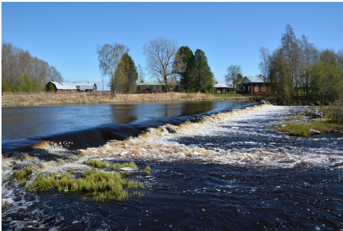
Kuva 24. Holmforsin pohjapato Lapväärtissä kuvattuna 14.5.2019 noin 12 m 3 /s virtaamalla. Kuva: Panu Orell.
