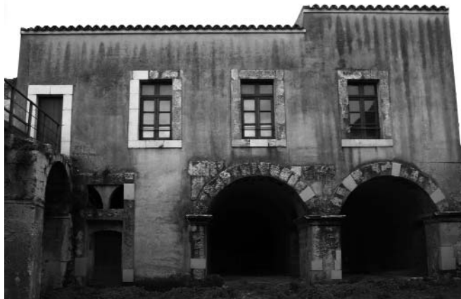
Fig. 13. Pietraperzia. Castello, cortile, fronte sud-occidentale.
