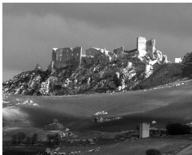
Fig. 2. Pietrapercia. Castello, fronte nord-ovest, stato attuale.
