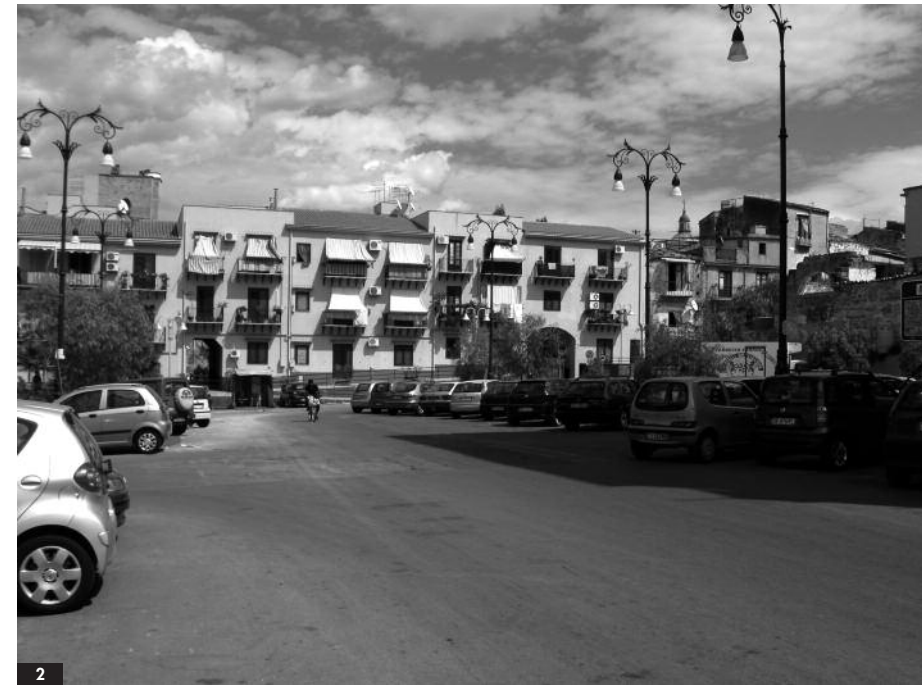
2. La piazza S. Nicolò all'Albergheria terminale della via Mongitore. A destra si nota il palazzo con l'arco che dà accesso alla piazzetta Baronio Manfredi, appena ricostruito. Prima di esso, ancora ruderi della guerra.
