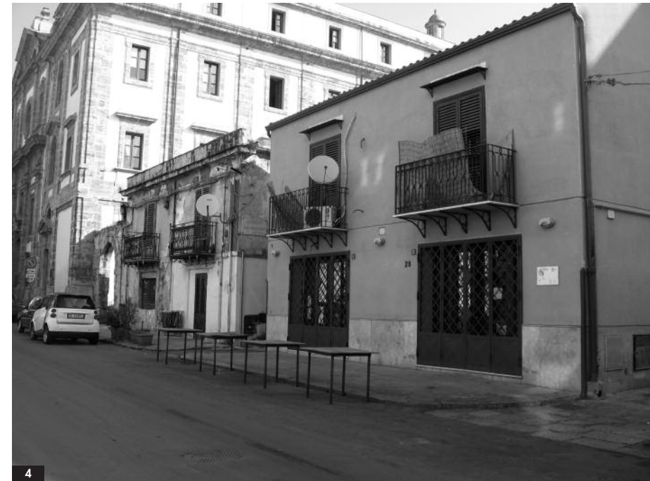
4. Testate dei catoi in vicolo I e II ai Crociferi, l'una recuperata e l'altra ancora degradata.
