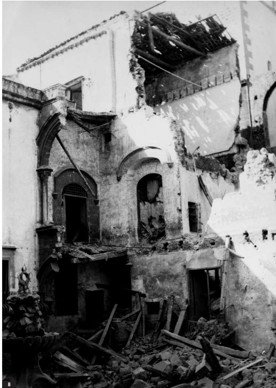
8. Danni bellici: il loggiato di Palazzo Abatellis, interamente crollato.
