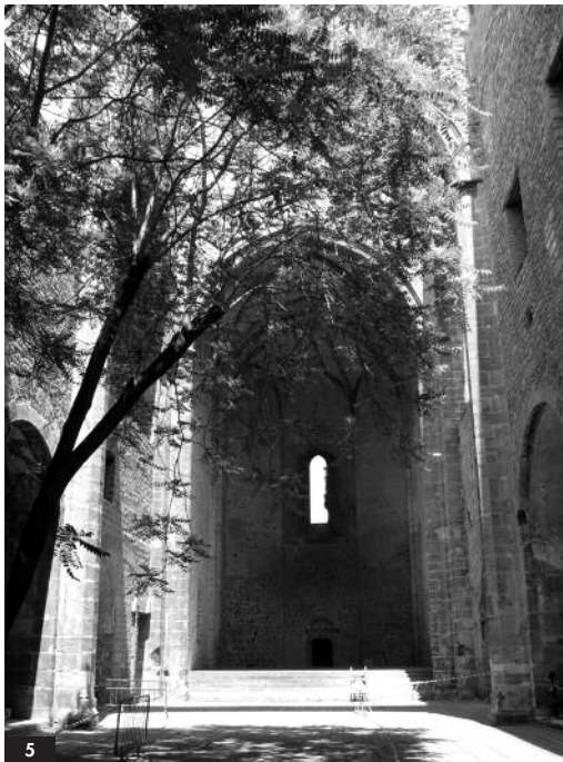
5. Interno della chiesa dello Spasimo, restaurata ma lasciata senza copertura.
