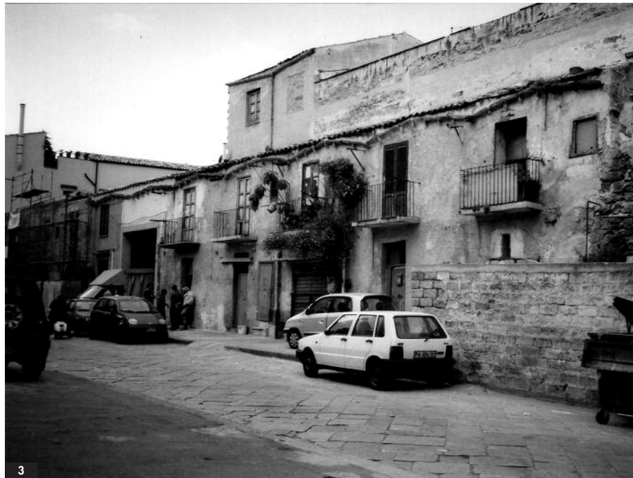
3. Catoi in via dello Spasimo in forte stato di degrado.
