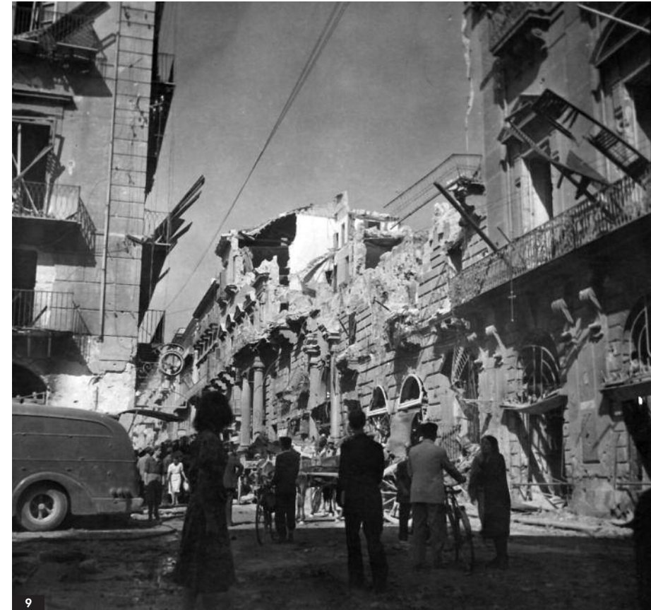
9. Danni bellici: la facciata di Palazzo Geraci su corso Vittorio Emanuele.
