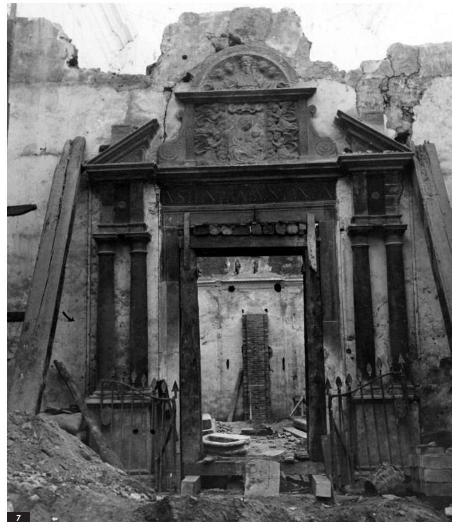
7. Danni bellici: resti dell'oratorio di S. Francesco, successivamente demolito.
