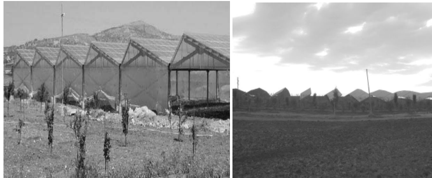
Fig. 1 - Fotovoltaico in agricoltura: a sinistra serre tradizionali con strutture fotovoltaiche; a destra strutture fotovoltaiche a terra (fonte: http://www.ecowave2012.blogspot.it/ ).
