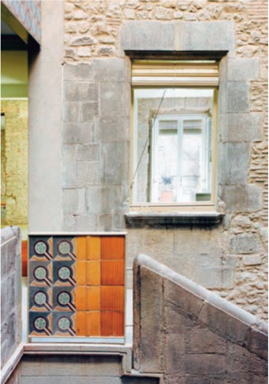
Casa Collage , particolare di un prospetto che mostra ancora il nuovo integrato con l'antico.
