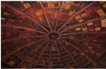
Figura 2. Vista interna della cupola.
