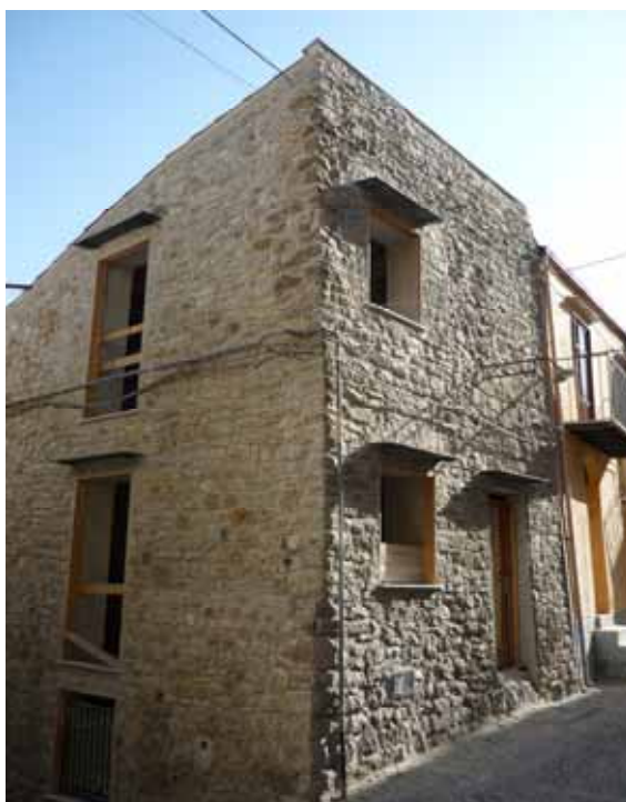
Fig. 2 - Unità residenziale in corso di recupero in via A. Faso (maggio 2010)
