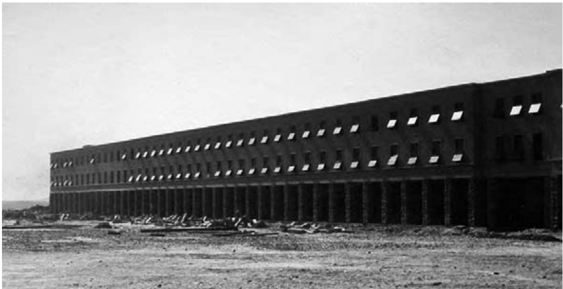
Fig. 5. Edificio I3/P ad abitazioni operaie, foto di cantiere
