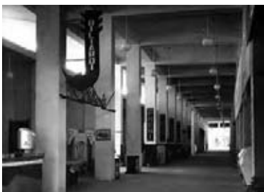
Fig. 5. PANTANO V., Interno del Padiglione Centrale, 1949
