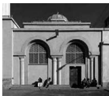
Fig. 12. Passaggio laterale ovest dopo la chiusura (foto 2005)
