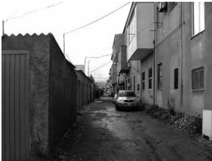
Fig. 8. Edificio I3/P, il fronte nord con i corpi aggettanti, costruiti per ampliare gli alloggi, che ne hanno trasformato la volumetria
