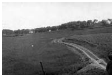
Fig. 1. La "collina uliva" prima dei lavori (Archivio Servizio Cristiano, Villaggio Monte degli Ulivi a Riesi)
