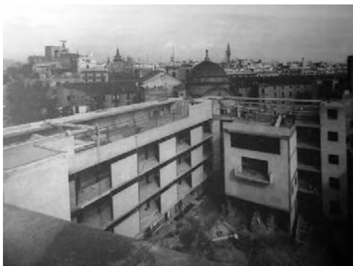
Fig. 3. SERT J. LL., TORRES CLAVE J., SUBIRANA J.B., Dispensario antitubercolare , foto di cantiere
