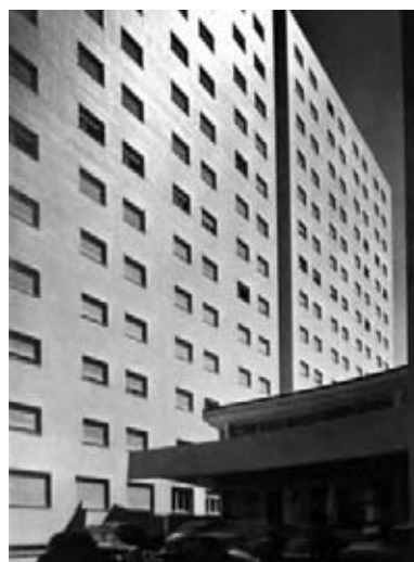
Fig. 1. MORETTI L., Casa-albergo di via Corridoni, Milano 1946, veduta d'epoca della facciata del corpo alto
