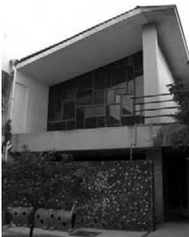
Fig. 5. Ricci L., Tempio Valdese, vista del fronte sul patio interno, 2007
