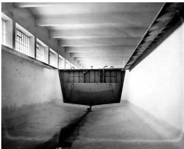
Fig. 12. La Vasca, interno con il bacino vuoto: in primo piano il battello porta, che serviva a suddividere il bacino in due per effettuare alcune prove sperimentali e permettere il ricambio parziale dell'acqua. CPA, Archivio Fot., 5° Reparto SMA, Roma
