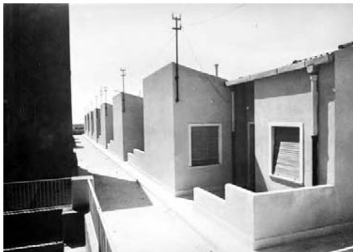
Fig. 1. La strada interna, foto d'archivio
