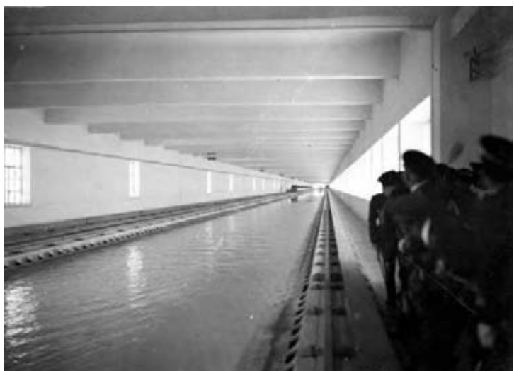
Fig. 11. La Vasca, interno da ovest durante una prova sperimentale. CPA, Archivio Fot., 5° Reparto SMA, Roma
