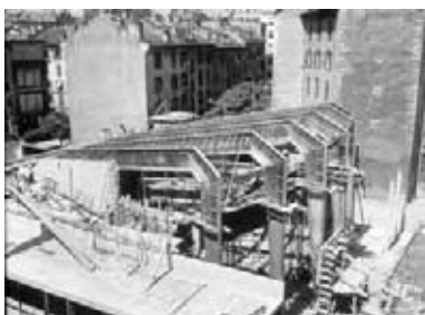
Fig. 5. Mont-Blanc Centre, la sala del cinema Plaza in costruzione: le grandi capriate in alluminio, di una portata di 40 metri, sono già in posizione (foto di M. Kettel)
