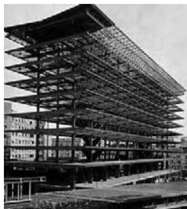
Fig. 8. LOPEZ R., HOLLEY M., edifici per la CAF, l'ossatura metallica della cosiddetta tour Lopez (foto di M. Kettel)
