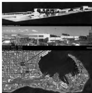
Fig. 1. MAZZONI A., Stazione marittima, Messina, stato di fatto
