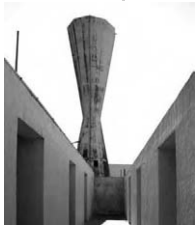
Fig. 6. Lido del Tirreno, serbatoio e cabine
