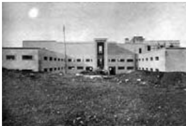
Fig. 9. Casa del Balilla, foto dal lato della corte delimitata dai corpi della palestra e del teatro
