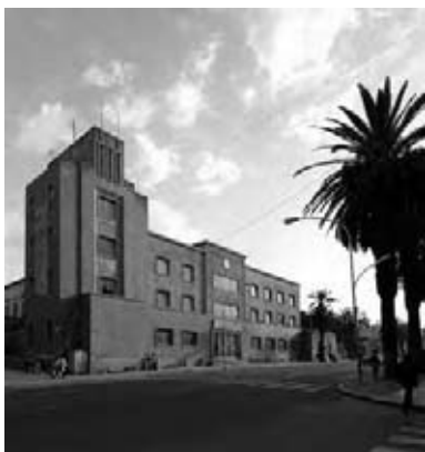
Fig. 2. SCLAFANI B., Casa del Fascio , Asmara 1940 (foto 2004)
