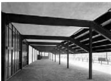
Fig. 12. Cinodromo Meridiana, vista del piano terra sotto la gradinata
