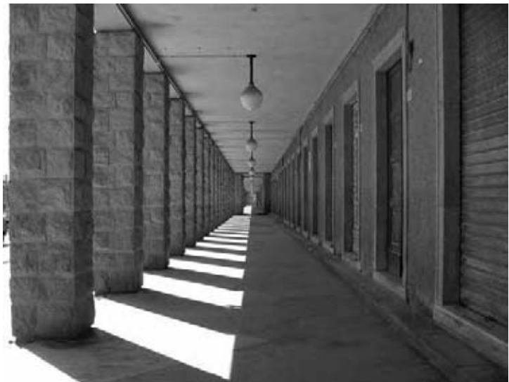
Fig. 6. Edificio abitativo I3/P, il porticato
