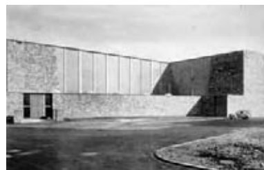
Fig. 13. SCHWARZ R., Chiesa cattolica S. Anna, Düren 1951-56, fotografia dello stato d'origine (da SCHWARZ R., Kirchenbau , Eidelberg 1960, p. 227)
