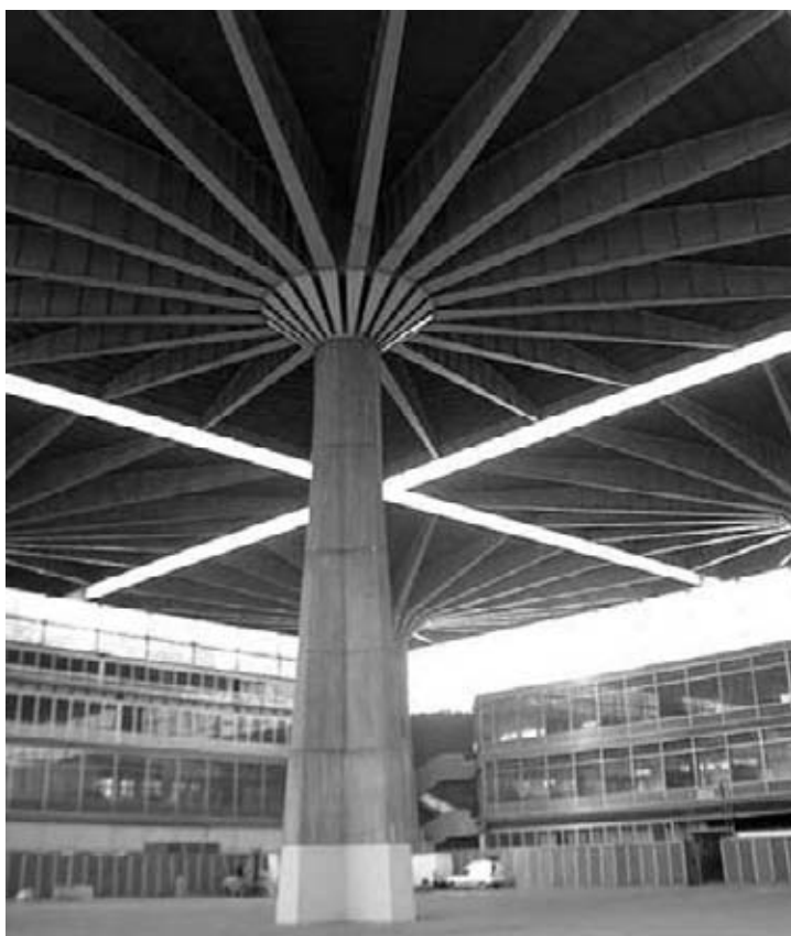
Fig. 15. NERVI P. L., Palazzo del Lavoro , Torino 1961, veduta interna con il caratteristico pilastro a fungo
