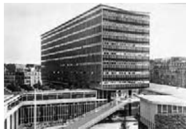
Fig. 7. LOPEZ R., HOLLEY M., edifici per la CAF, vista sopraelevata da rue du Dr. Finlay verso la corte di servizio, con gli accessi alla stamperia, ai parcheggi e la grande scala per il personale (foto di M. Kettel)
