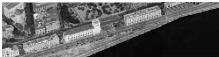
Figg. 1-3. SAMONA G., VIOLA G., La Casa del Fascio, Messina 1940, vedute aeree
