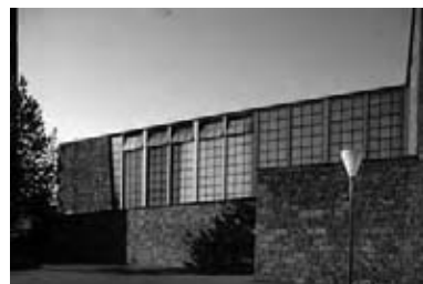
Fig. 14. SCHWARZ R., S. Anna, Düren. Lo stato precario delle facciate in vetro-cemento aveva offerto il pretesto per una pesante modifica: il vetro-cemento è stato sostituito da una finestratura in vetro colorato, progettato da Ludwig Schaffrath, agli inizi degli anni 90. Finito, annientato l'effetto di un volume di luce bianca appena trattenuto dalla filigrana descritta dal vetro-cemento
