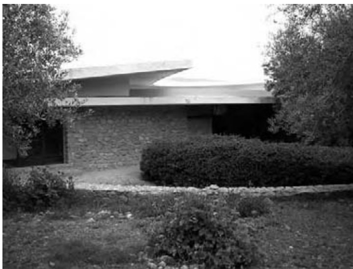
Figg. 12-13. Scuola Officina Meccanica, stato di fatto 2005-06
