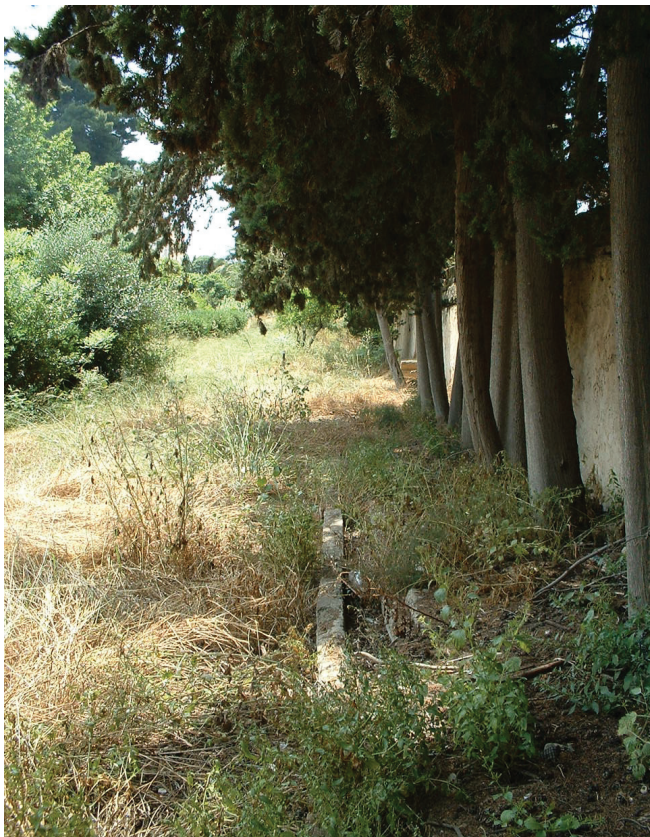
Foto 9 - Le canalizzazioni, realizzate con spallette in muratura di 10 cm. di spessore, completamente ricoperte di vegetazione e terra.
