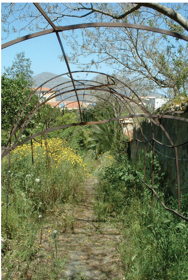
Foto 17 - Questa foto rappresenta lo stato del berceau di destra, volgendo le spalle alla terrazza. Difficile ipotizzare altra possibile causa dello svergolamento degli elementi del berceau , se non quello di un atto di vandalismo. Dal momento che non avrebbe senso il recupero, l'unica via percorribile è quella dello smontaggio del berceau esistente e della ricostruzione in situ di una struttura analoga.
