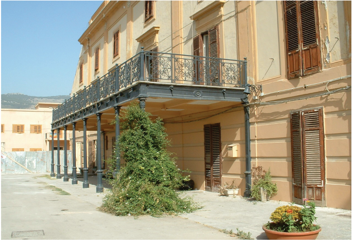
Foto 3 - Il portico in ghisa realizzato dalla Fonderia Oreteca su progetto di Ernesto Basile. Ancora ben conservato, la sua eleganza gli consente di essere l'unico elemento capace di esprimere ancora un'idea di decoro in un contesto ormai degradato.
