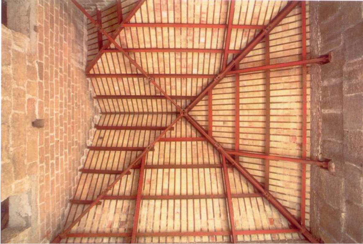
Figura 6: Struttura della copertura dei corpi quadrangolari
