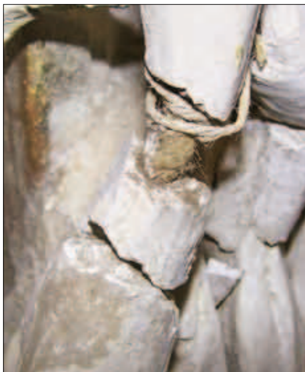
Fig. 8 – Giacomo Serpotta, Cappella di San Girolamo , 1696, chiesa di Sant’Orsola, Palermo, particolare di uno dei tralci inferiori durante la fase di pulitura. Dalle lacune della malta si può osservare l’anima interna costituita da una corda.
