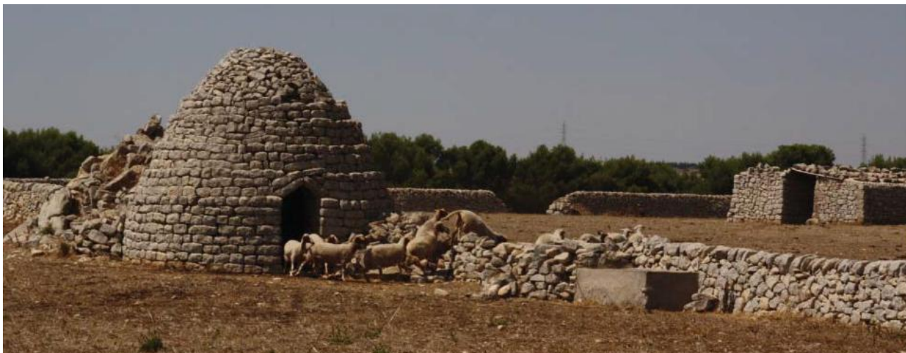
Fig. 2: Capanno con copertura a falsa cupola in pietra ( Pagghiaru ), in C.da Celonia (RG). Foto di L. Dipasquale
