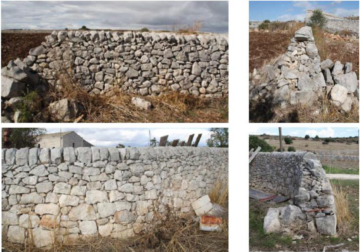
Fig. 1: Vista dell'apparecchiatura muraria e della sezione di due muri a secco ragusani. Foto di L. Dipasquale
