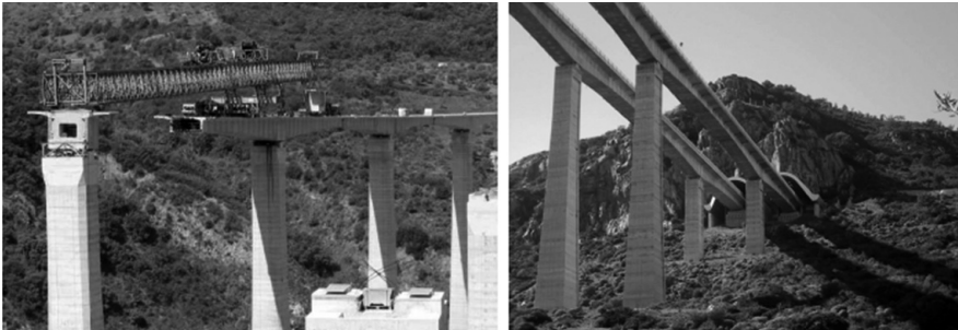
Fig. 8 – Realizzazione di ponti a conci in cemento armato precompresso per l'autostrada Messina-Palermo
