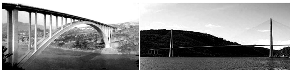
Fig. 21 – Ponte ad arco di Wanxian in Cina e ponte strallato Skarnsundet in Norvegia
