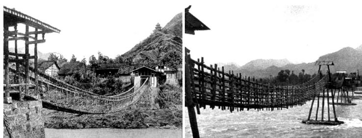
Fig. 22 – Ponti a catenaria dell'antichità in Cina
