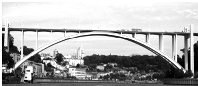
Fig. 18 – Ponte di Arrábida sul fiume Douro a Porto, Portogallo. 1963. E. Cardoso
