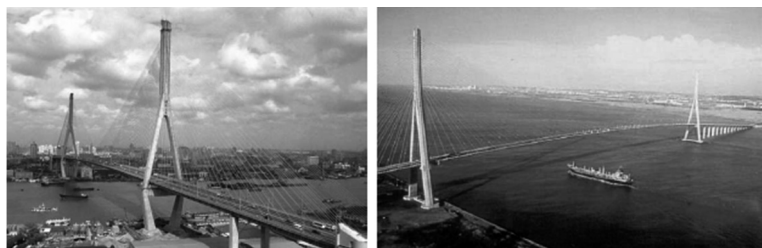
Fig. 11 – Ponte Yangpu e ponte di Normandia
