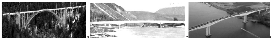
Fig. 7 – a) Viadotto di Langwies nella linea ferroviaria da Coira ad Arosa, Svizzera. Arco di calcestruzzo armato. 100 metri di luce. 1914. E. ZUBLIN. b) Ponte di Dorénaž sul Rodano . Svizzera. Ponte a travata in cemento armato con luci 30.5+45+30.5 metri. 1933. A. SARRASIN. c) Ponte Gateway in Brisbane , Australia. 260 metri di luce. 1985. Record del mondo dei ponti a travata in calcestruzzo
