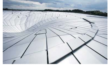
Fig. 5 - La copertura "a nuvole".
