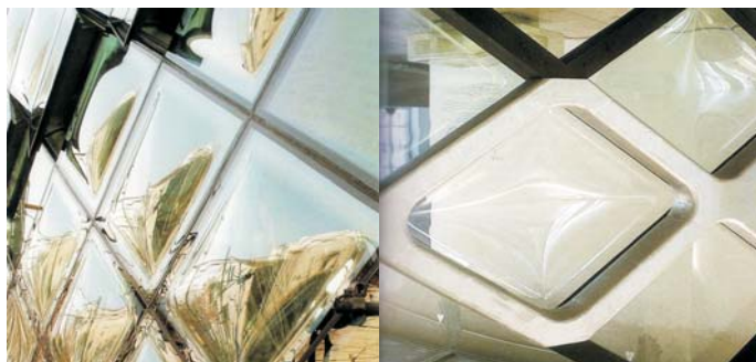
Fig. 5 - La pelle vista dall'esterno (a sinistra) e gli infissi interni rivestiti (a destra).
