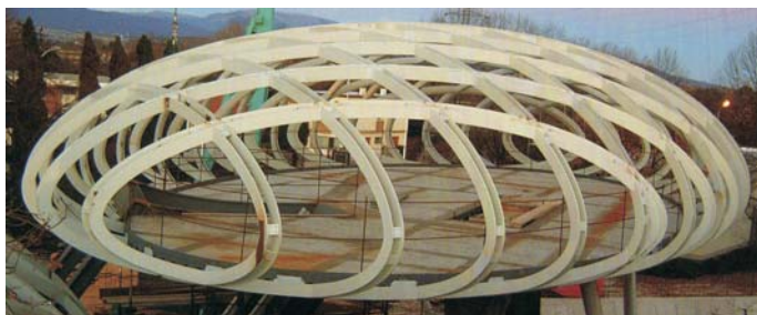
Fig. 7 - La struttura dell'ellissoide costituita da coppie di centine arcuate.
