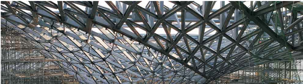
Figg. 6 e 7 - L'intelaiatura del doppio imbuto durante la costruzione.
