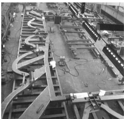
Fig. 22 - Lavorazione delle travi scatolari.
