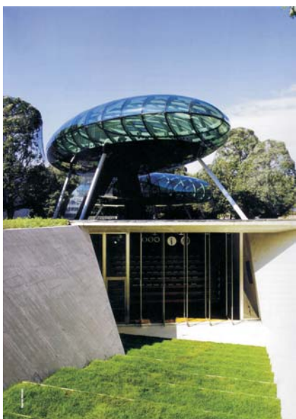
Fig. 2 - La gradinata che porta all’auditorium e che funge anche da platea all’aperto.
