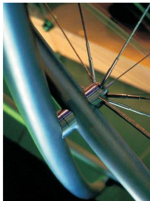
Fig. 3 - Dettaglio della struttura primaria in tubi di acciaio e della maglia di cavi.
