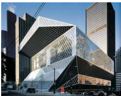
Fig. 1 - Il volume sfaccettato della biblioteca visto dalla strada.
