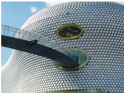
Fig. 3 - Il ponte aereo che mette in collegamento diretto il piano del ristorante con il parcheggio.
