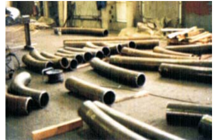
Fig. 23 - Lavorazione delle travi tubolari.
