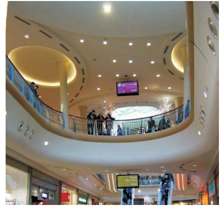
Fig. 4 - L'atrio a tutt'altezza illuminato dal lucernario centrale.
