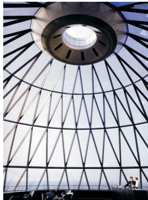
Fig. 7 - La copertura voltata.
