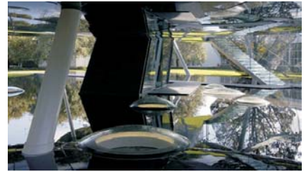
Fig. 4 - I lucernari che illuminano l'auditorium sottostante.
