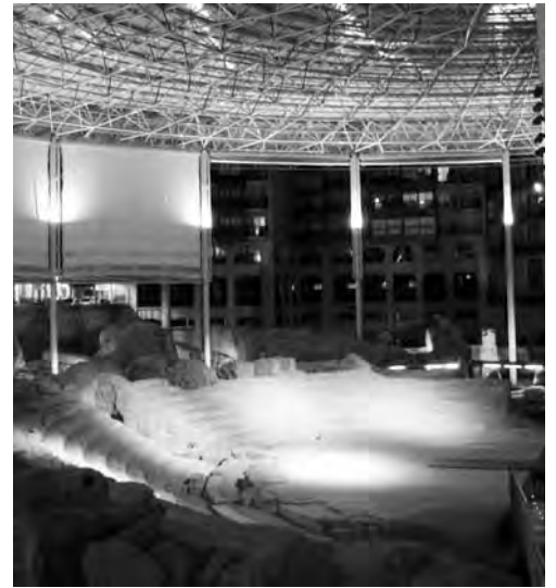
La copertura realizzata per proteggere i resti del Teatro romano di Saragozza (Spagna).
