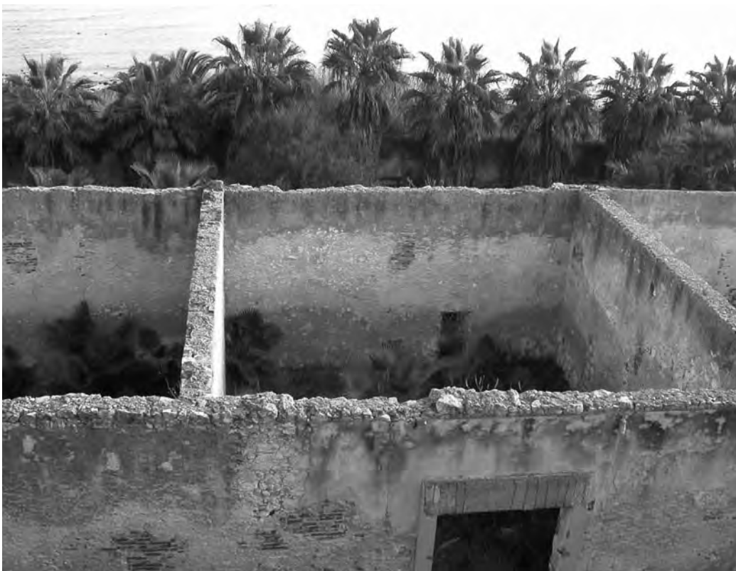
I ruderi degli Edifici 8 e 9.
