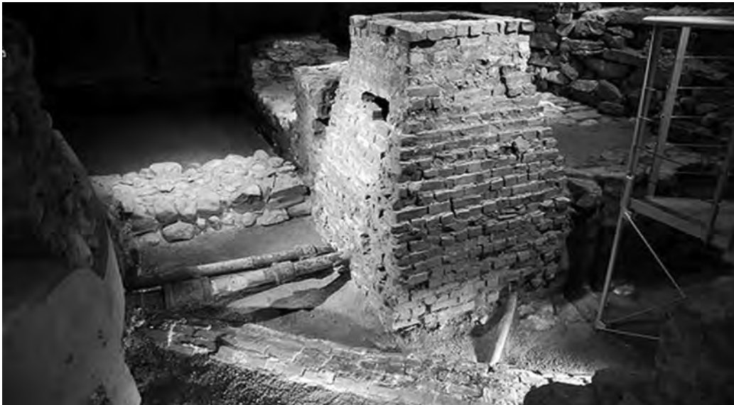
Struttura di un vecchio camino tra le rovine.
