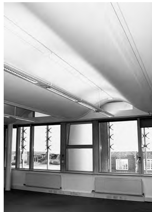
Particolare del soffitto sinusoidale.
