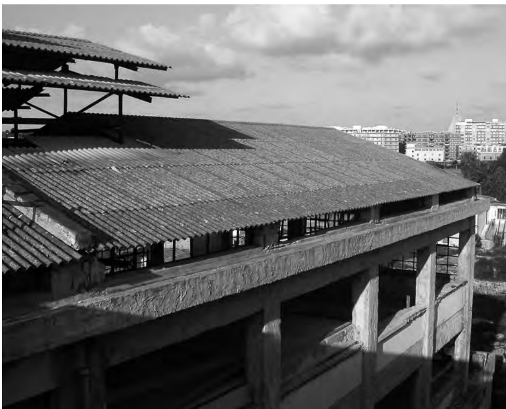
L'Edificio 6: l'area di stoccaggio e il sistema delle coperture.
