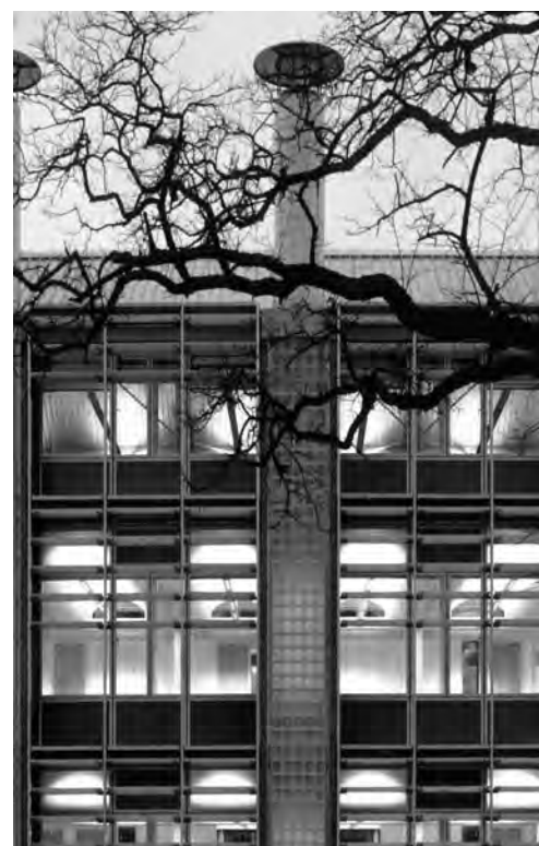
Vista notturna del BRE con particolare del camino per la ventilazione.
