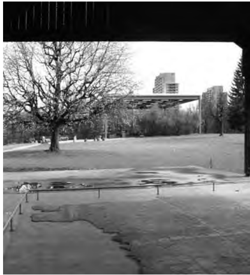
La copertura realizzata per la protezione di un mosaico dell'antica colonia di Augusta Raurica (Svizzera).
