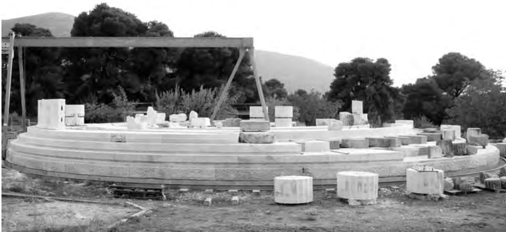
In alto, la Stoá-ábaton e in basso, la Thólos di Policleto: fasi di cantiere del restauro riconfigurativo (2008).
