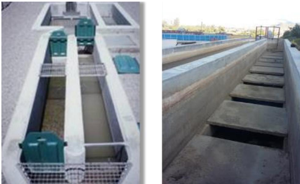
Figura 3 Canales desarenadores de flujo variable
