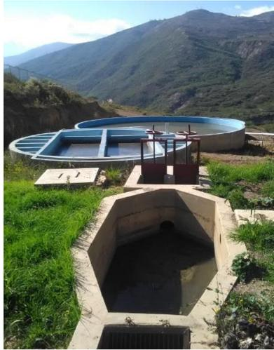
Figura 9 Filtro Anaerobio de Flujo Ascendente (PTAR de Independencia, Bolivia)
