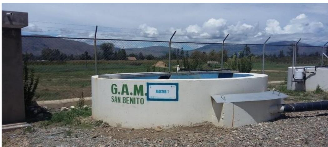
Figura 7 Reactor Anaerobio de flujo Ascendente (PTAR de Linde Paracaya, Bolivia)
