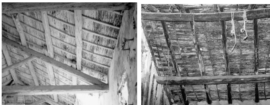
Figura 5 - Baglio Anselmi e Casolare in c.da Gurgo con arcarecci in castagno ed abete rosso
