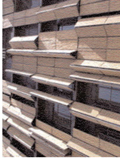
Porzione della facciata.
