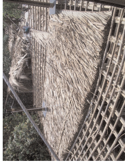
Dettaglio della struttura in bambù che sorregge la copertura.
