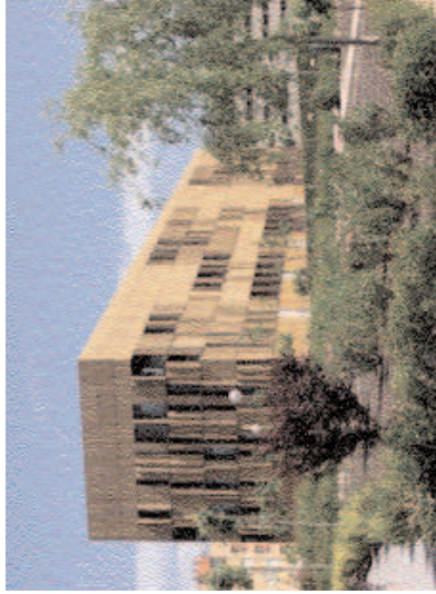
La diversa regolazione delle gelosie modifica costantemente il prospetto dell'edificio.
