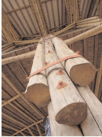
Struttura multi-pilastri in legno. (foto di M. Cárdenas Laverde).
