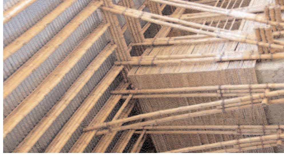
Dettaglio della struttura in bambù che sorregge la copertura.
