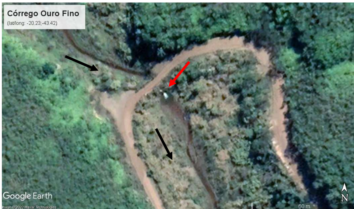
Figura 5: Estrutura de arte viária (bueiro tubular) entre o córrego Ouro Fino e uma estrada na área de estudo. A seta preta indica a direção do escoamento da água, de montante para jusante, e a seta vermelha indica a saída do escoamento da água no bueiro. A pluma branca observada é característica de água em queda. Essa queda d'água evidencia um degrau que dificulta e/ou impede o deslocamento da fauna aquática de jusante para montante. Fonte: Google Earth.
