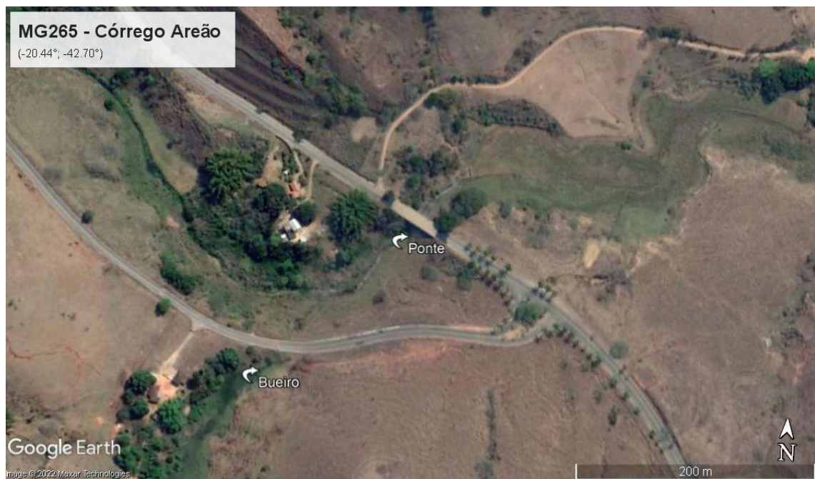
Figura 7: Identificação de obras de arte especiais viárias: bueiro e ponte. Note que a ponte tem pouca interferência no fluxo livre da água, enquanto no bueiro o curso d'água fica subterrâneo por alguns metros. Fonte: Google Earth.
