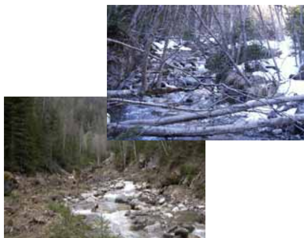
Figura 4.21 – Tratto del t. Codalonga prima e dopo le "pulizie d'alveo".
