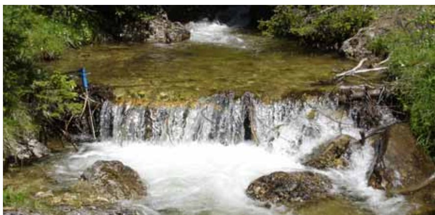
Figura 5.27 – Log-step nel t. Andraz: si può notare il sedimento bloccato a monte del salto, e la pozza che si è formata a valle.
