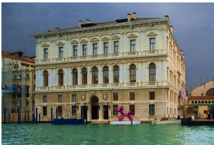
Figura 141: Facciata esterna sul Canal Grande di palazzo Grassi, l'edificio utilizzato come esempio per ricavare le caratteristiche energetiche della tipologia edilizia da considerare.
