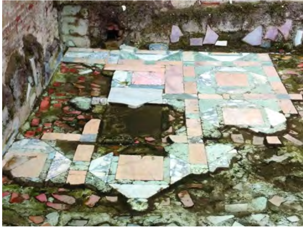
a – Villa dei Quintili (n°cat. 99). Pavimento in opus sectile del tepidario L1, RMS-VQ26 .
