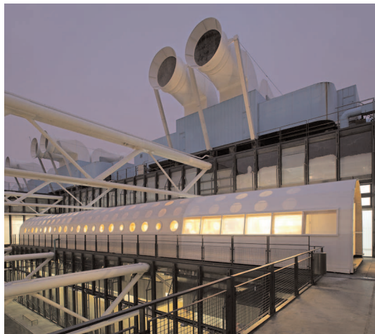
Paper Temporary studio di Shigeru Ban. Parigi, 2004. Vista laterale.
