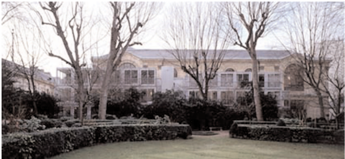
Edifici provvisori per la scuola di Belle Arti, Paris-Malaquais. (LABFAC).
