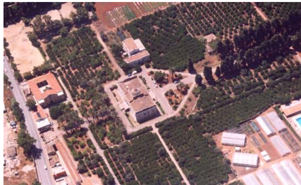
Figura 3: Vista aerea del Ginnasio.
