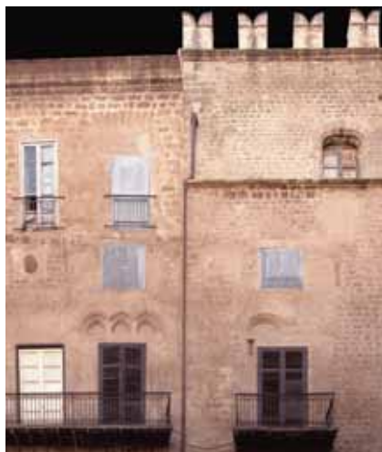
2. Fotopiano del prospetto nord, particolare.
