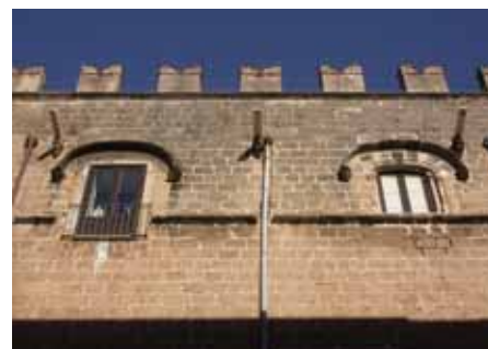
3. Prospetto principale, particolare.
