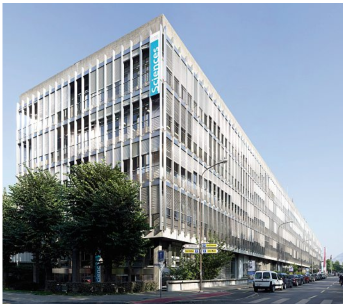
Le bâtiment de Sciences II (photo Régis Golay)
