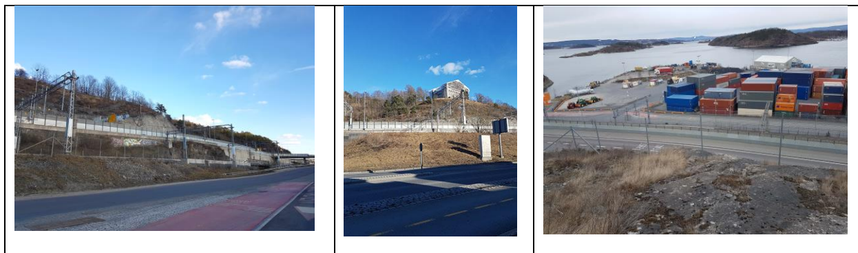
Figur 17. Fra Kongshavnveien opp mot jernbanen og E18 (til venstre) og opp mot Kongshavn videregående skole (i midten). Til høyre, fra toppen av vegskjæring ned mot sørsippen av Grønlikaia
