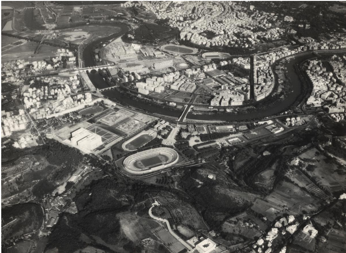
Aerial view of the Foro Italico in 1959. Source: Archivio fotografico Gigliola Del Debbio.
