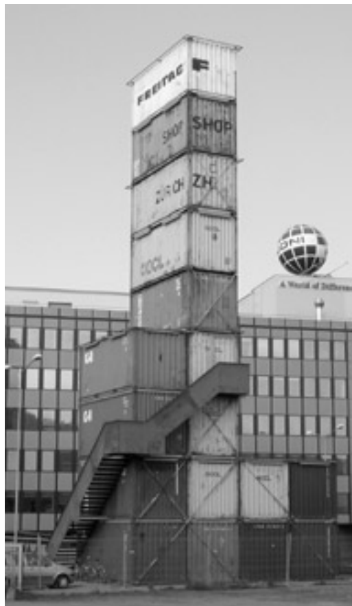
Abb. 7_24 2006 eröffnet in Zürich, neben Bahnanlagen und einer vielbefahrenen Zufahrtsstraße, der neue Flagstore der Firma Freitag, die Taschen aus recycelten LKW-Planen herstellt. Das Gebäude besteht aus insgesamt 17 auf- und nebeneinander gestapelten, ausrangierten Schiffscontainern. Wie es in einer Infobroschüre der Firma heißt: »So entstand in Zürich in Bonsai-Wolkenkratzer: Niedrig genug, um unter der behördlichen Hochhaus-Linie zu bleiben, hoch genug, um selbst bei hart gesottene Besuchern Schwindelgefühle aufkommen zu lassen.«
