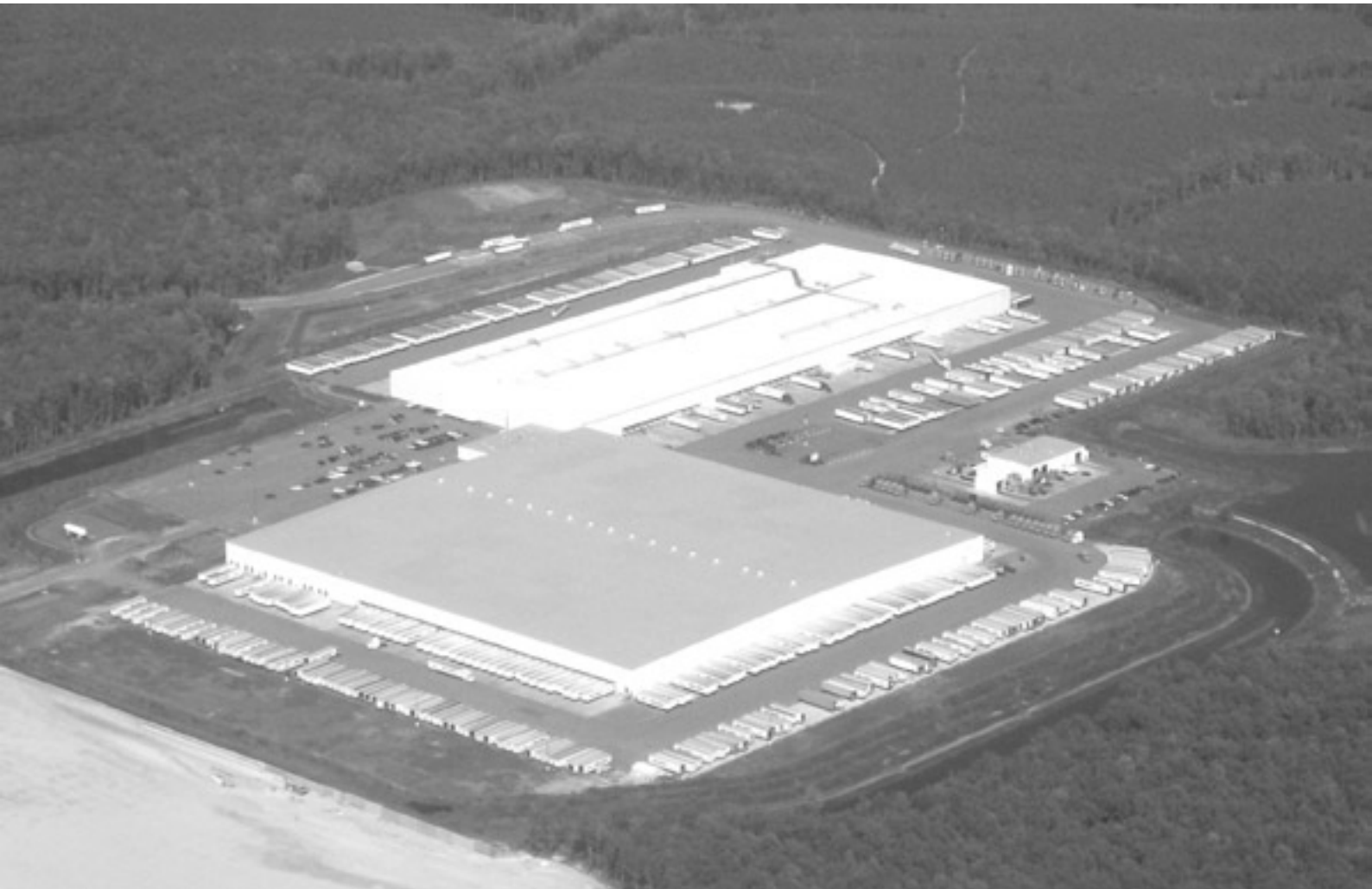
Abb. 5_1 Luftaufnahme eines Wal-Mart Distribution Center im US-Bundesstaat Virginia.
