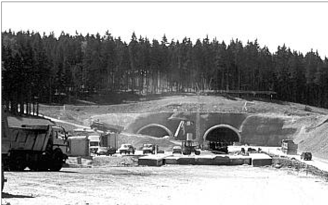
Bild 1 Südportal des Rennsteigtunnels
