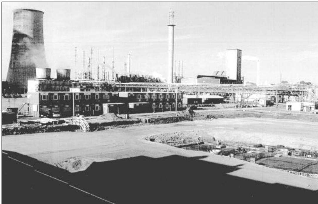
Bild 5 Fertigung der Abwassergruben, Stand am 22. Juni 1999
