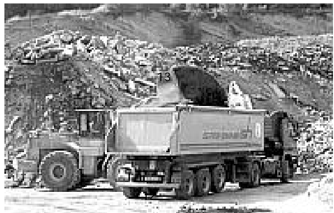
Bild 16 Abtransport von aufbereitetem Bauschutt
