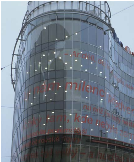
1 | Jean Nouvel, „Anděl“ – Detail der Ecke
