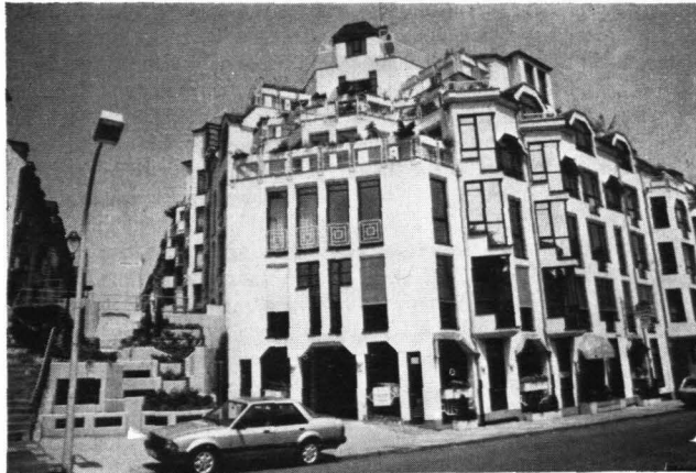
7 Wohn- und Geschäftshaus an der Beethovenhalle. Bonn. 1981–1982. Architekt Hanns Uelner
