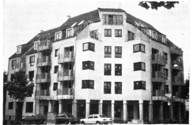
8 Sozialer Wohnungsbau. Bonn, Clemens-August-Straße. 1986. Architekt Walter von Lom (Köln)
