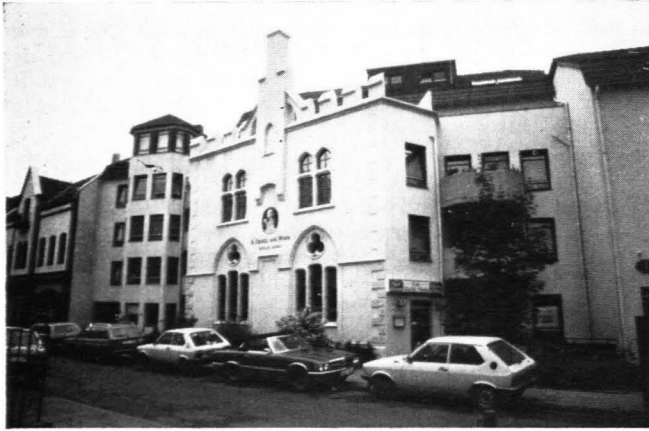
3 Bonn, Königstraße. – Abriß des gründerzeitlichen Gebäudes der Kaffeerösterei Zuntz bis auf die Hauptfassade, die zur „Nobilitierung“ der neuen Wohnarchitektur dient. 1983–1984
