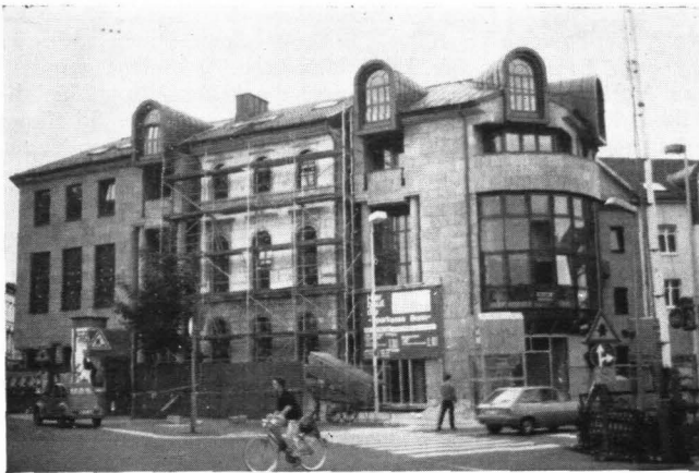
5 Sparkasse Bonn, Filiale Arndtstraße. Fertigstellung Herbst 1986. Architekten: Erlen und Partner (Köln). — Einbeziehung einer Gründerzeitfassade eines ausgekernten Südstadt-Wohnhauses.
