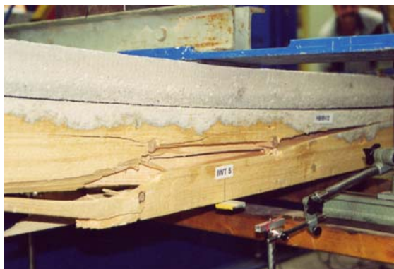
Abb.5-35: An Dübelstangen fortschreitender Riss in der Randlamelle
