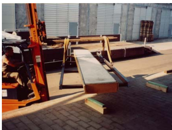
Abb.5-21: Umsetzen der Verbundplatten mittels Lastgeschirr
