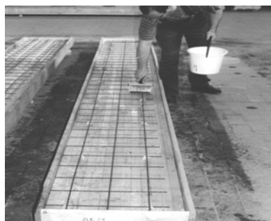
Abb.5-12: Befeuchtung der Platten vor dem Betonieren
