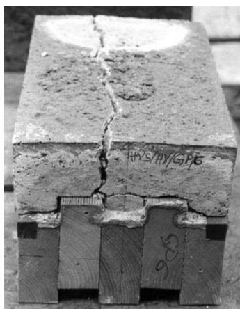
Abb.3-29: Schwindrisse im Geopolymerbeton am Beispiel HVS/HV/GP/6
