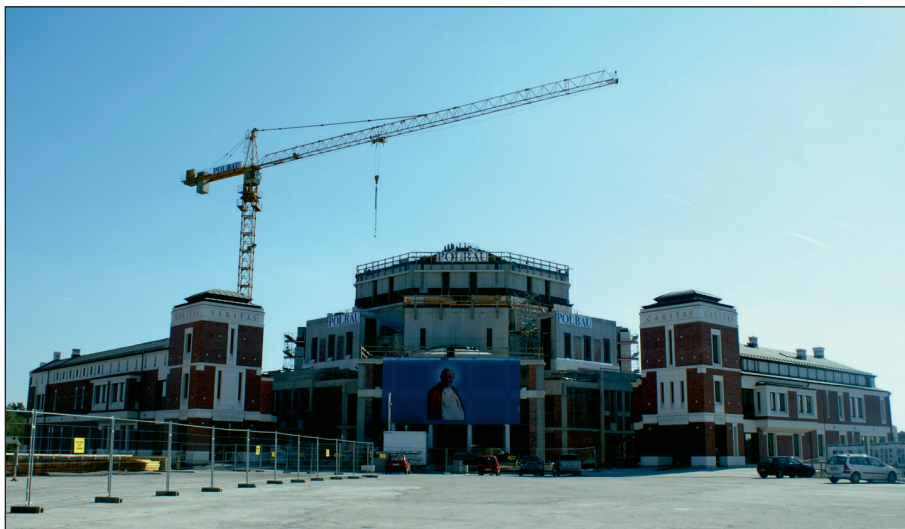
Fot. 3. Centrum Jana Pawła II „Nie lękajcie się” w trakcie budowy, wrzesień 2012 r. (fot. M. Liro)
